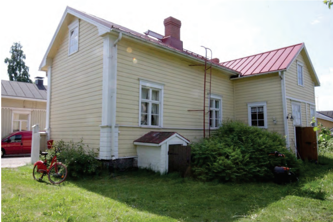
Kuva 3. Kohteen asuinrakennuksessa on pihan puolella iso umpikuisti, josta on sisäänkäynti rakennukseen sekä kulku ullakkokerrokseen. Kellariin on myös sisäänkäynti pihalta. Pihajulkisivussa ei ole haukkaikkunoita. Rakennuksen ulkonäköä on kuvailtu edellä luvussa "Rakennuksen kuvaus".
