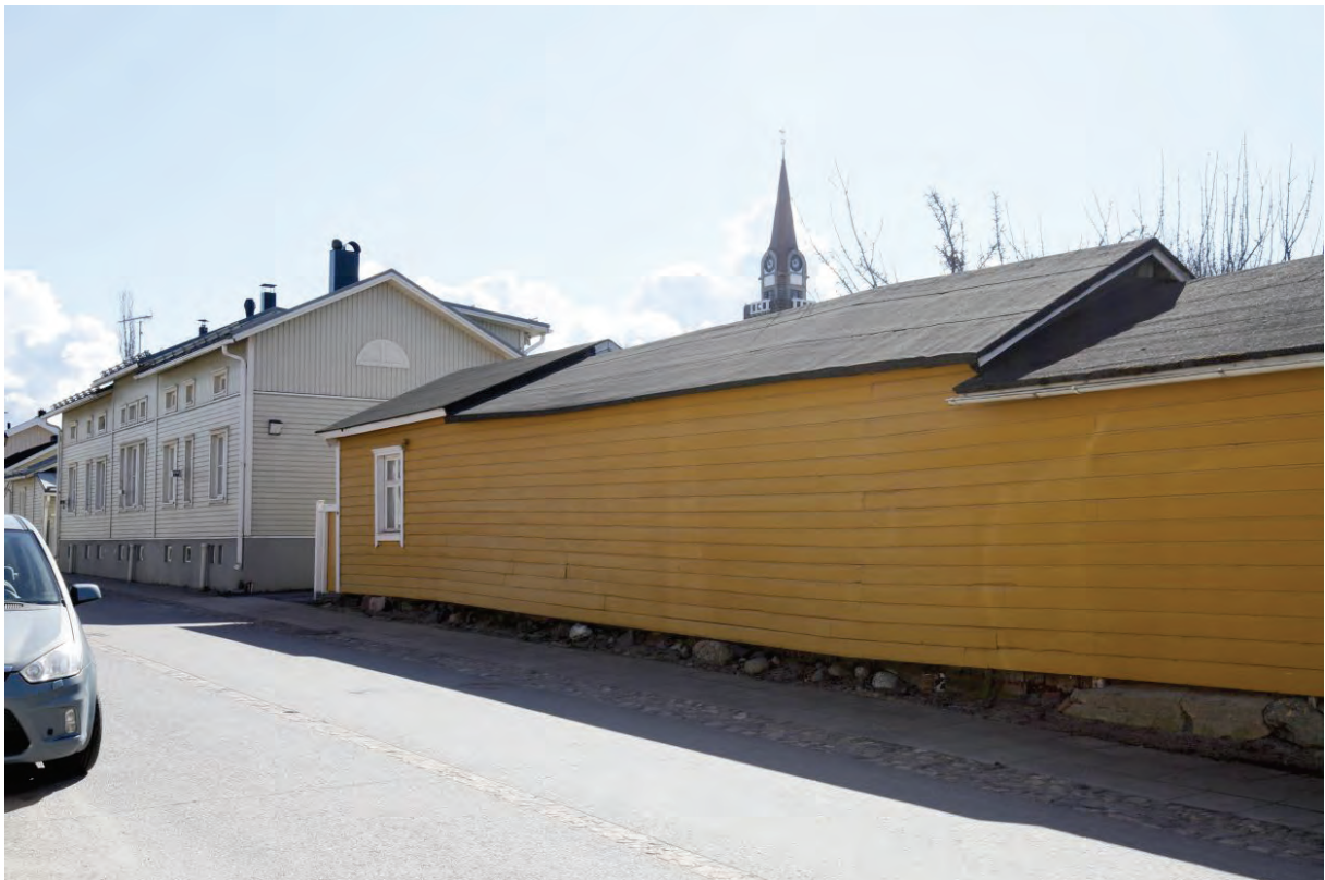
Kuva 4 Kohteen talousrakennukset on vuorattu yhtenäisesti vaakalaudoituksella Saaristokadun puolella. Talousrakennusten ollessa matalia vaikutelma on aitamainen. Useasta eri rakennusosasta koostuvan rakennusrivistön perustukset ovat eläneet ja saaneet seinän aaltoilemaan. Taustalla näkyy Raahen kirkon torni. Rakennuksen ulkonäköä on kuvailtu edellä luvussa "Rakennuksen kuvaus".
