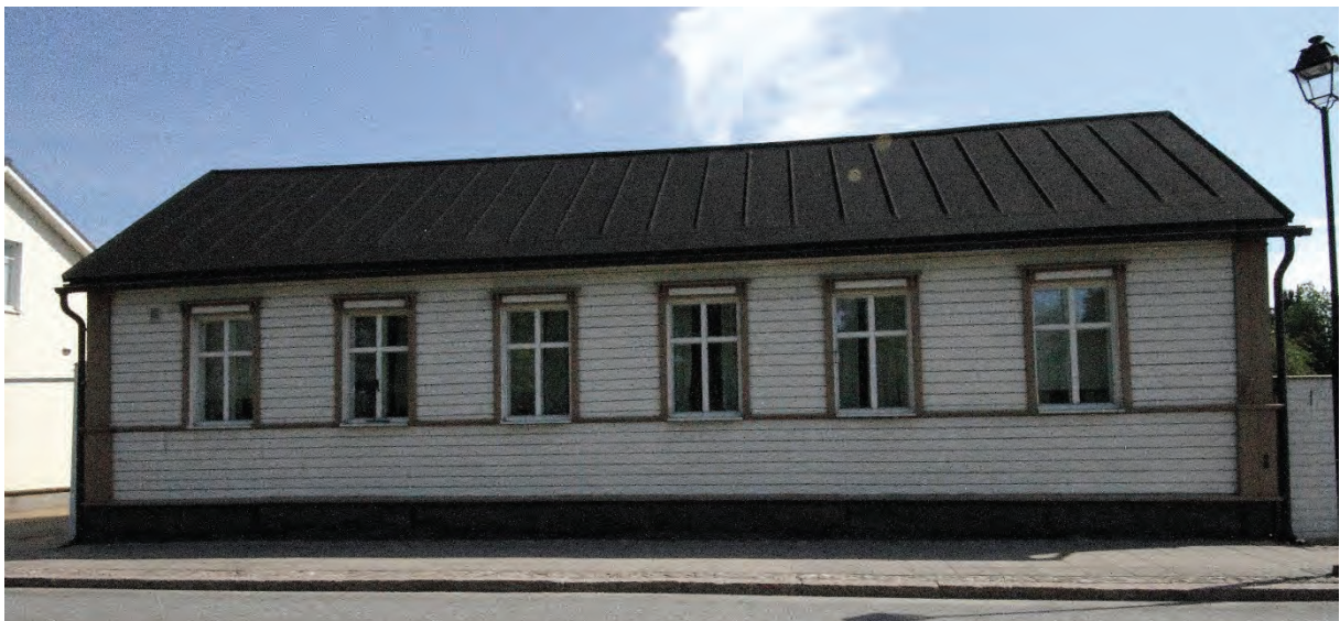
Kuva 3. Kohteen asuinrakennuksen kadunpuoleinen julkisivu. Kadulle päin on kuusi ikkunaa. Rakennuksen ulkonäköä on kuvailtu edellä luvussa "Rakennuksen kuvaus".
