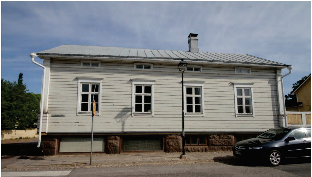
Kuva 2. Kohteen isomman asuinrakennuksen Corténkadun puoleinen pitkä julkisivu. Kivijalassa on kaksi isompaa ikkunaa liiketiloihin ja kaksi pienempää ikkunaa alkuperäiseen kellariin. Rakennuksen ulkonäköä on kuvailtu edellä luvussa "Rakennuksen kuvaus".
