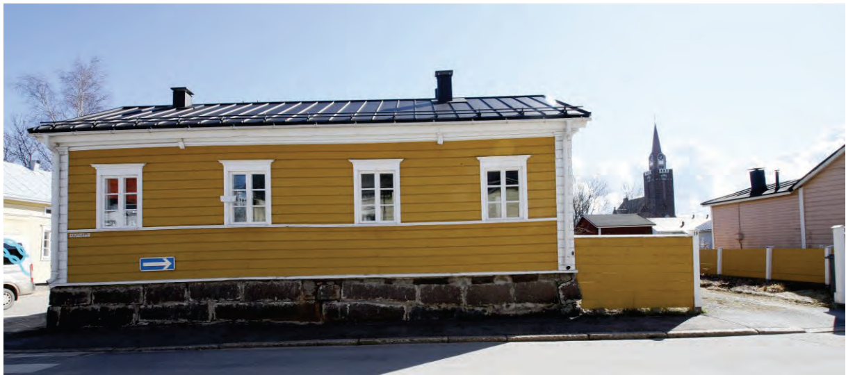
Kuva 2 Kohteen päärakennus ja lauta-aita Kauppakadun puolella. Aidassa on pilarien rajaama aukko nurmeltuneelle pihatielle, mutta ei porttia. Rakennuksen ulkonäköä on kuvailtu edellä luvussa "Rakennuksen kuvaus".
