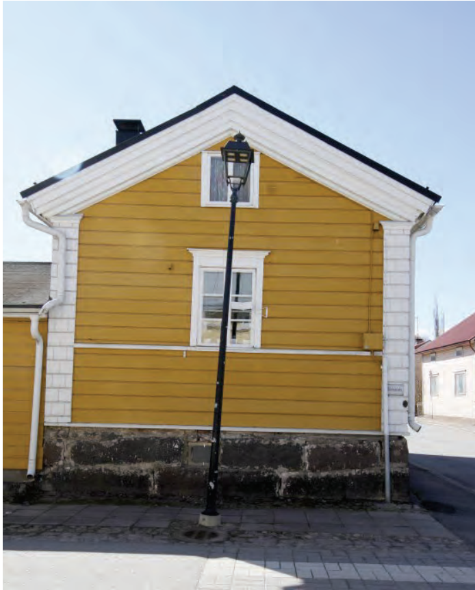
Kuva 3 Kohteen päärakennuksen pääty Saaristokadun puolella. Rakennuksella on melko korkea kivijalka lohkokivistä ja julkisivua jäsentää koristeelliset nurkkapilasterit ja vaakalista ikkunoiden alla. Rakennuksen ulkonäköä on kuvailtu edellä luvussa "Rakennuksen kuvaus".
