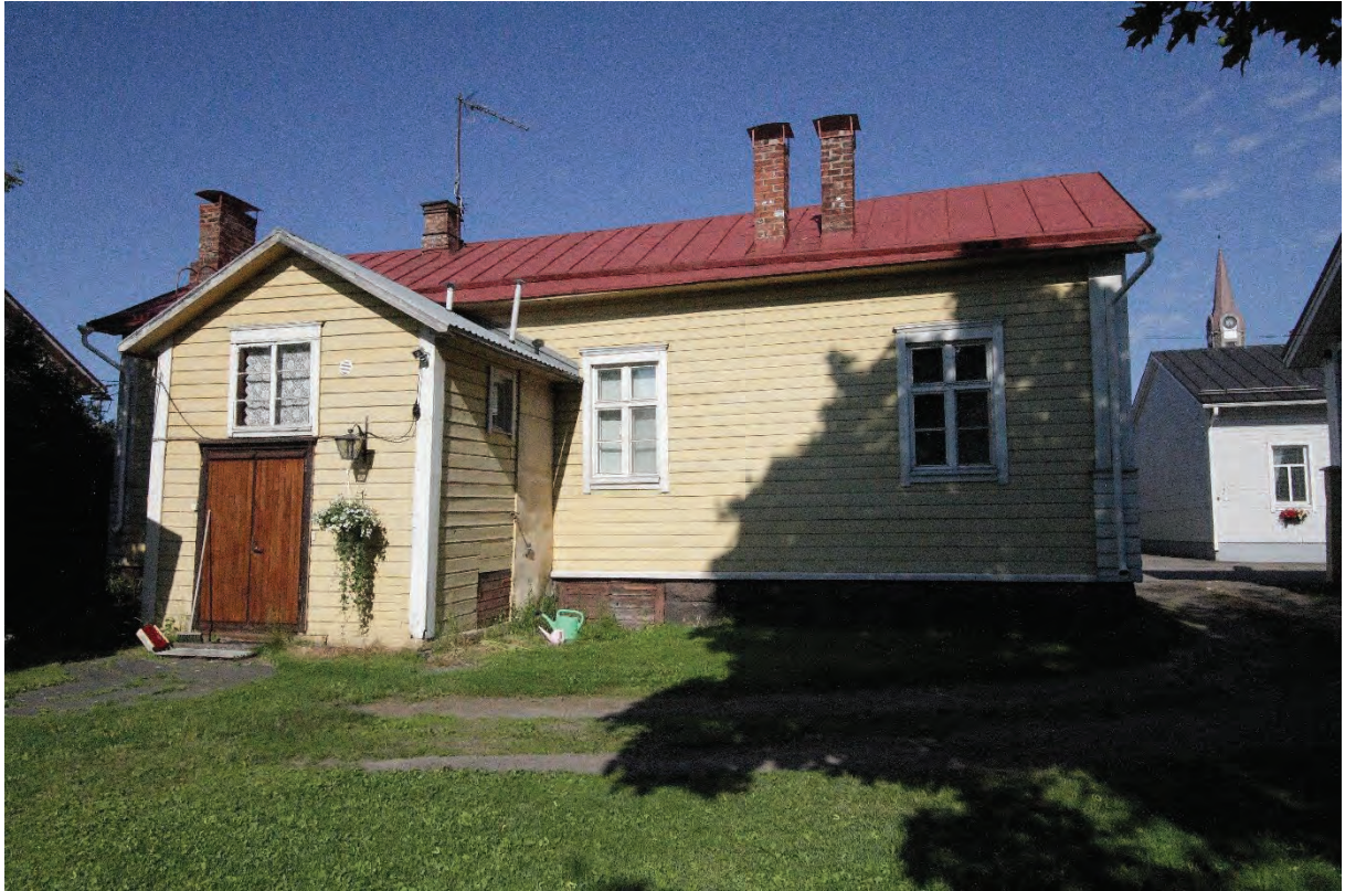
Kuva 3 Kohteen päärakennuksen pihapuoleinen julkisivu. Sisäänkäynti on umpikuistin kautta parioven kautta. Portaat ovat kuistin sisällä. Kellarin sisäänkäynti jää kuistin taakse piiloon. Kirkon torni näkyy pihalle talojen välistä. Rakennuksen ulkonäköä on kuvailtu edellä luvussa "Rakennuksen kuvaus".
