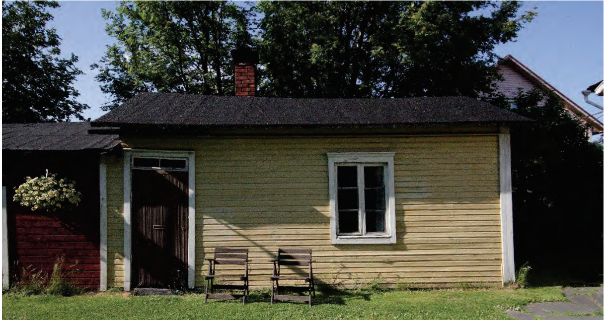
Kuva 5 Talousrakennuksen itäpäädyn asuintupa. Tuvassa on 6-ruutuinen pystyikkuna ja sormipaneloitu, ruskeaksi maalattu ovi, jossa on postiluukku. Rästäslinja on hieman ylempänä kuin rakennuksen muilla osilla. Rakennuksen nurkissa on hyvin yksinkertaiset pilasteri piiloponttilaudasta. Niillä ei ole jalustaa eikä varsinaista kapiteelia. Seinäpintaa jäsentää seinän yläreunassa oleva vaakalista, joka jatkuu pilasterin päällekin. Listan yläpuolelta sinä on vuorattu muutaman laudan levyisellä piiloponttilaudoituksella ja pilasteri kapenee listan yllä hieman kapeammaksi. Rakennuksen ulkonäköä on kuvailtu edellä luvussa "Rakennuksen kuvaus".
