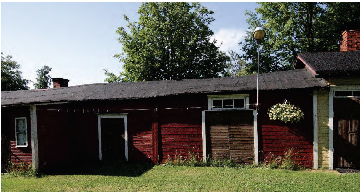
Kuva 6 Kuvan oikeassa laidassa näkyy liiteri ja vasemmassa reunassa makasiini. Liiterin ovi on leveä pariovi, makasiinin ovi on kapeampi. Kumpikin vaakalaudoitettu ovi maalattu ruskeaksi. Rakennuksen ulkonäköä on kuvailtu edellä luvussa "Rakennuksen kuvaus".
