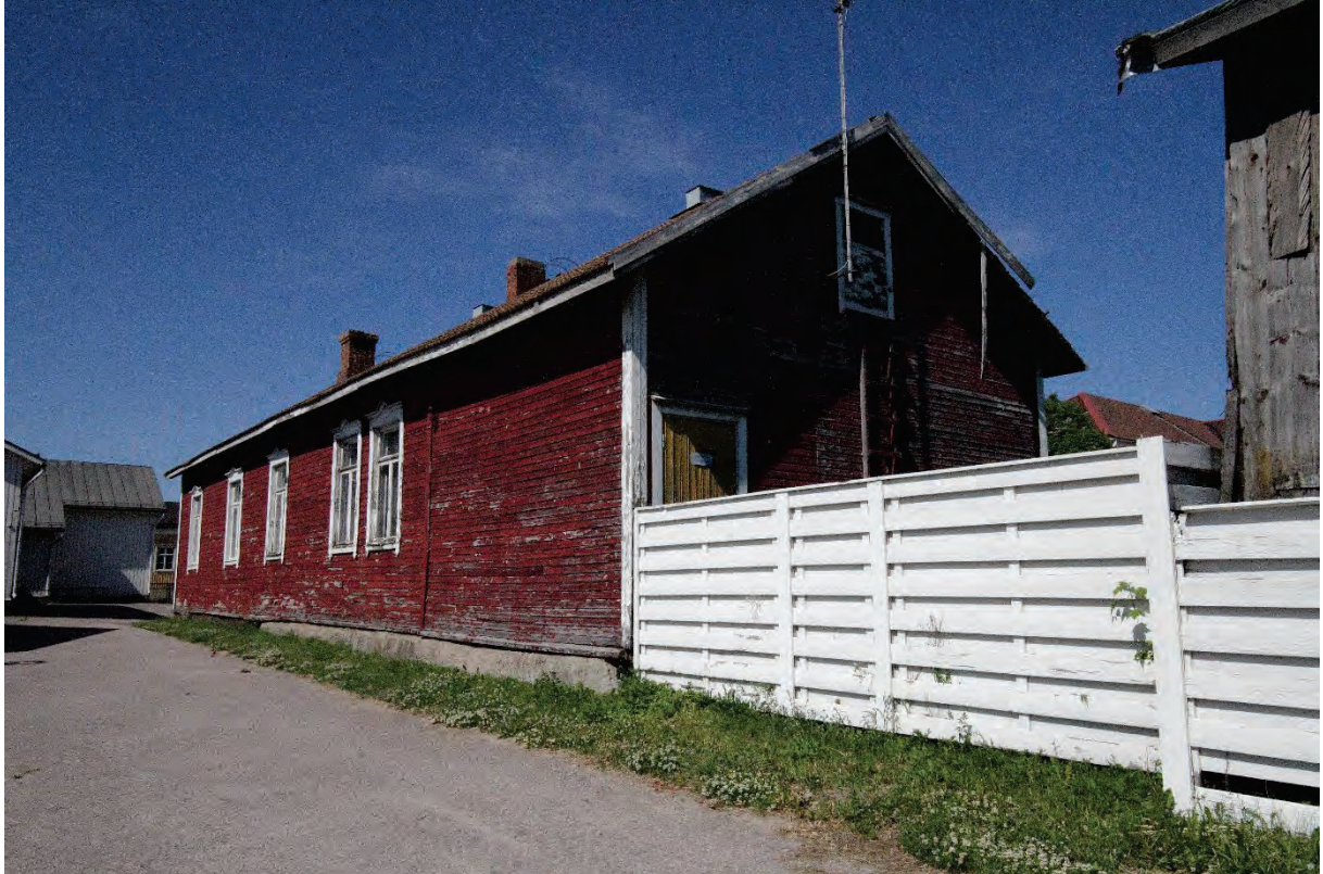
Kuva 2. Tontin eteläisivulle sijoittuu asuinrakennuksena käytetty piharakennus, jonka päädystä alkaa naapuritontillekin jatkuva korkea lauta-aita. Rakennuksen ulkonäköä on kuvailtu edellä luvussa "Rakennuksen kuvaus".
