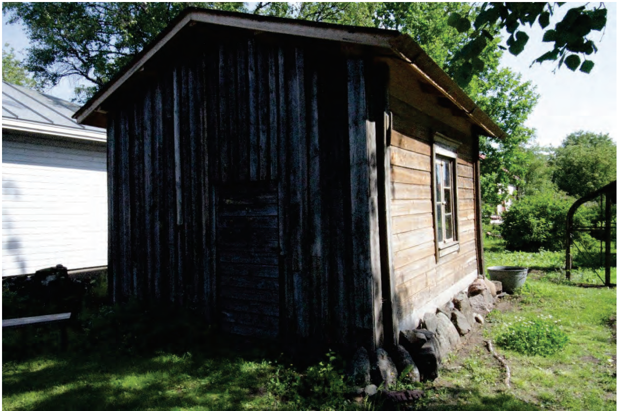
Kuva 6. Pihalla oleva sauna 1920-luvulta. Saunaa on kunnostettu vanhaa rakennustekniikkaa kunnioittaen. Rakennuksen ulkonäköä on kuvailtu edellä luvussa ”Rakennuksen kuvaus”.
