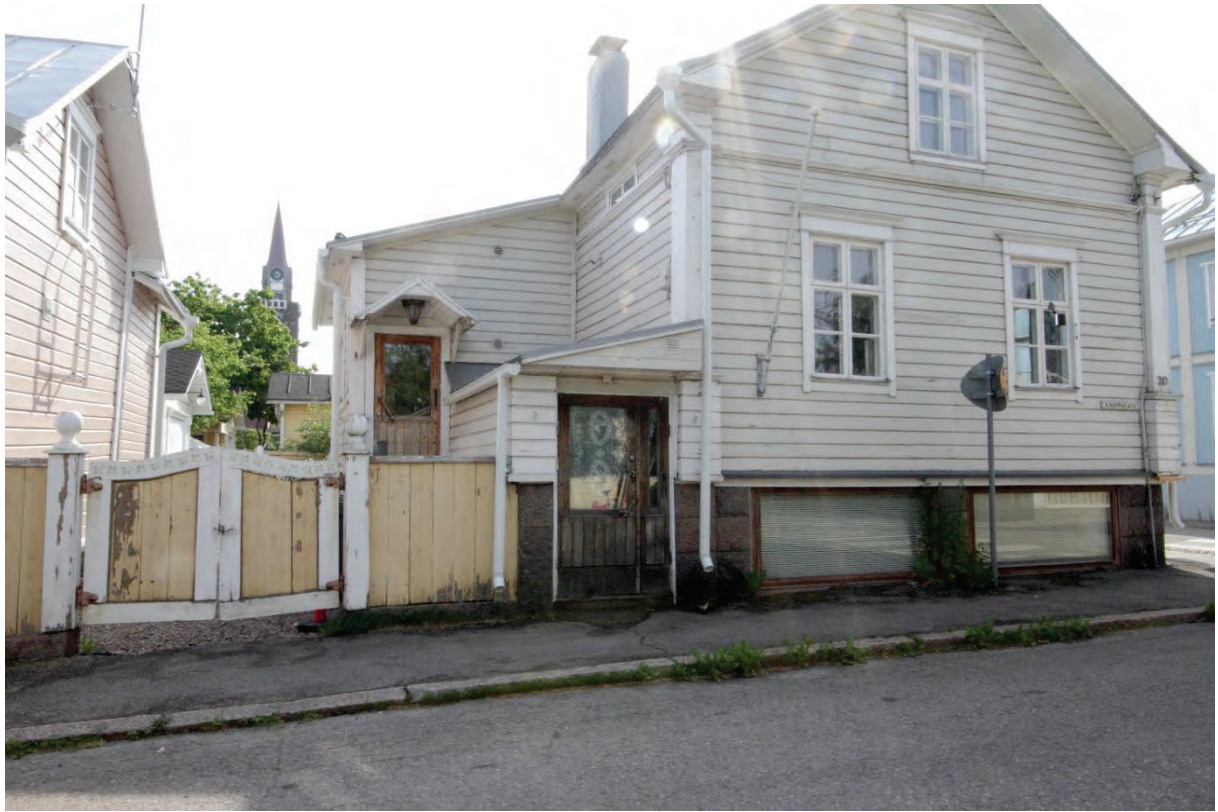
Kuva 3. Kohteen isomman asuinrakennuksen päätyjulkisivu Kauppakadulla. Kellarissa on isot ikkunat entisiin liiketiloihin ja kadulta johtaa ovi kellariin vieviin portaisiin. Isomman ja pienemmän asuintalon välissä on aita ja koristeellinen portti. Portin pylväiden päässä on pyöreät koristeet ja portin ylälaidassa on kasviaiheiset koristemaalaukset. Talojen välistä näkyy kirkon torni. Rakennusten ulkonäköä on kuvailtu edellä luvussa "Rakennuksen kuvaus".
