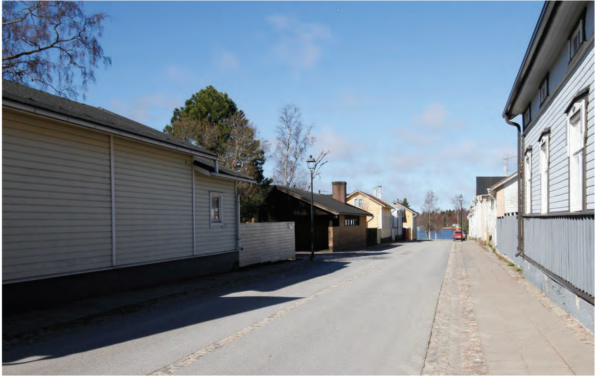
Kuva 4 Näkymä Kauppa- ja Saaristokadun risteyksestä länteen Pikkulahdelle. Kuvan vasemmassa reunassa näkyy kohteessa oleva Saaristokadun suuntainen uudisosa ja uudisosan jatkeena oleva lauta-aita. Matala keltatiilinen 1970-luvun asuinrakennus sijaitsee samalla tontilla, mutta omassa pihapiirissään. Sen takana kadun varressa on vanhoja asuinrakennuksia samoin kuin kadun toisella puolella kohdetta vastapäätä. Rakennuksen ulkonäköä on kuvailtu edellä luvussa ”Rakennuksen kuvaus”.
