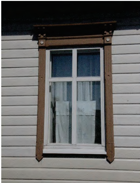
Kuva 5. Rakennuksen neliruutuiset ikkunat on uusittu vanhan mallin mukaan. Koristeellisissa palkistokehyksissä on konsolien kannattama lippalauta, koristeruusukkeet ja geometrisiä koristekaiverruksia.
