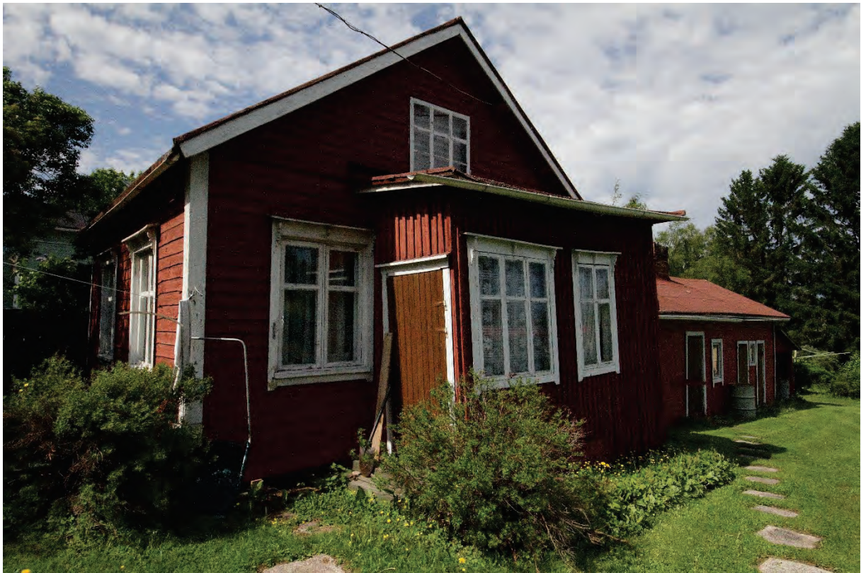
Kuva 4 Pihapiirin länsireunalla on entinen syytinkirakennus, jossa on ollut asukkaita syytingillä ja vuokralla. Siipiosassa on nykyisin sauna. Rakennuksen ulkonäköä on kuvailtu edellä luvussa ”Rakennuksen kuvaus”.
