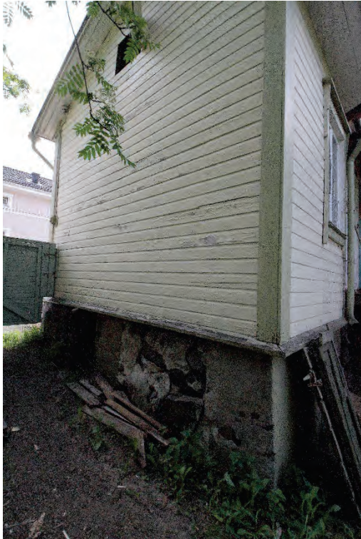
Kuva 4 Vanhan asuinrakennuksen itäpäätä. Kivijalka on melko korkea ja tehty osittain luonnonkivistä, osittain betonista. Rakennuksen päädyssä näkyy portti Saaristokadulle.
