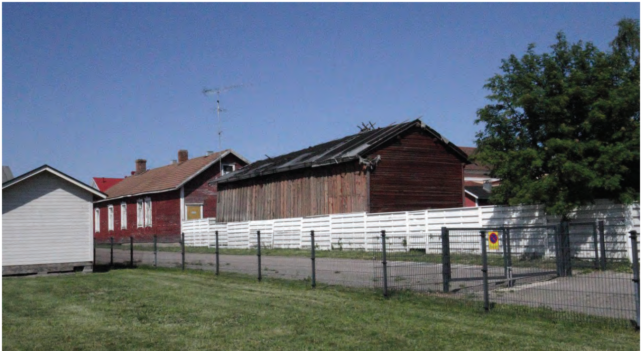
Kuva 3. Talousrakennuksen eteläjulkisivu puiston puolella. Kuvassa etualalla näkyy leikkipuiston nurmikenttää ja leikkipuiston metalliaita sekä leikkipuiston varistorakennus. Leikkipuiston aidan ja kohteen tonttia rajaavan valkoiseksi maalatun vaakalaudoitetun aidan välissä on kävelytie. Kohteen talousrakennus näkyy kuvan keskellä. Sen vasemmalla puolella on naapuritontin perällä oleva asuinrakennus.
