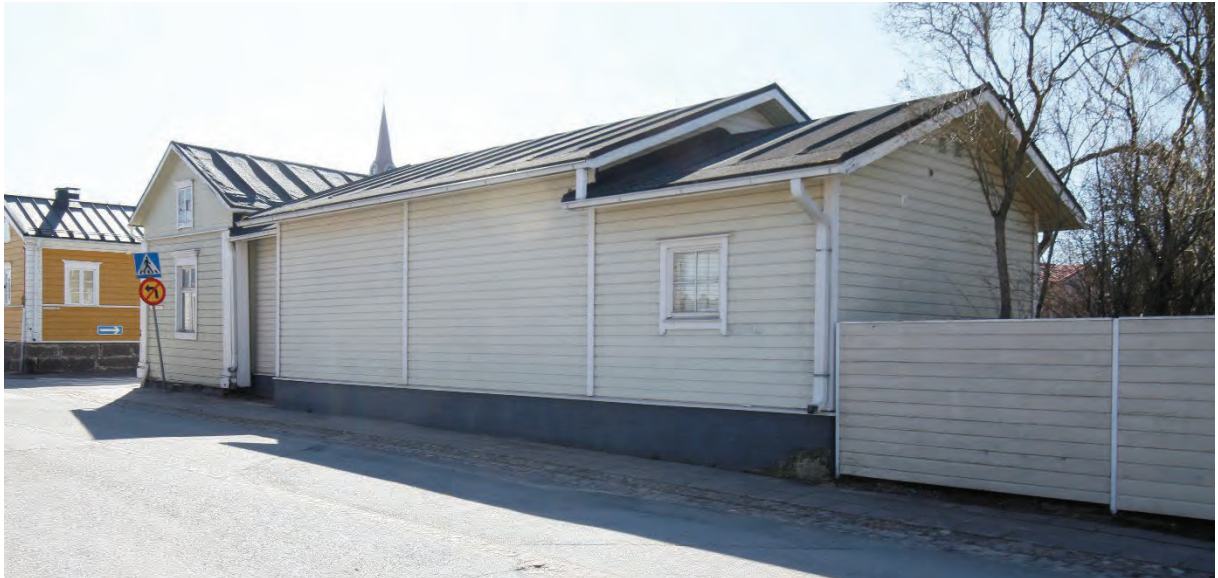
Kuva 3 Kohteen päärakennusta on jatkettu uudisosalla Saaristokadun varrella. Uudisosan massoittelu mukailee paikalla olleen vanhan rakennuksen massoittelua. Keskellä on hieman korkeampi rakennusosa, jonka länsipäädystä on matalampi osa. Uudisosan ja vanhan asuinrakennuksen välillä on hieman sisään vedetty rakennusosa. Tonttia rajaa umpinainen lauta-aita. Rakennuksen takaa näkyy Raahen kirkon tornin huippu. Rakennuksen ulkonäköä on kuvailtu edellä luvussa "Rakennuksen kuvaus".
