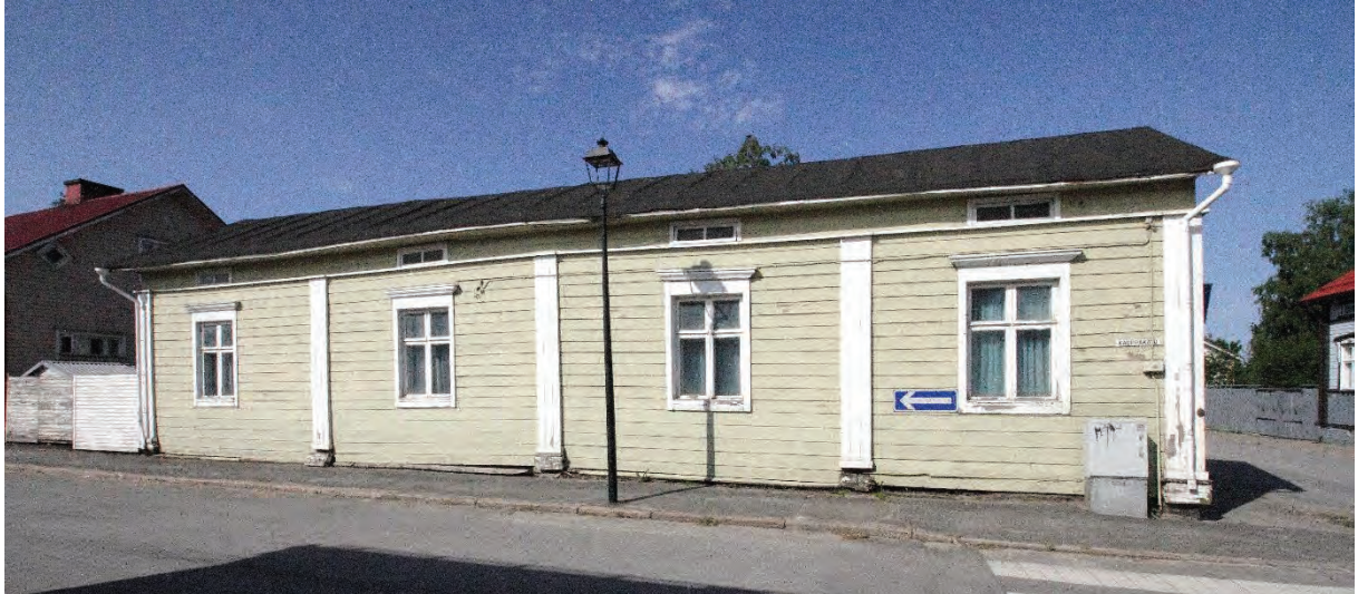
Kuva 2 Kohteen päärakennuksen Kauppakadun puoleinen pitkä julkisivu. Julkisivua jäsentää nurkka- ja julkisivupilasterit ikkunoiden välissä. 4-ruutuisten pystyikkunoiden yllä on 2-ruutuiset matalat haukkaikkunat ullakkokerroksessa. Rakennuksen ulkonäköä on kuvailtu edellä luvussa "Rakennuksen kuvaus".
