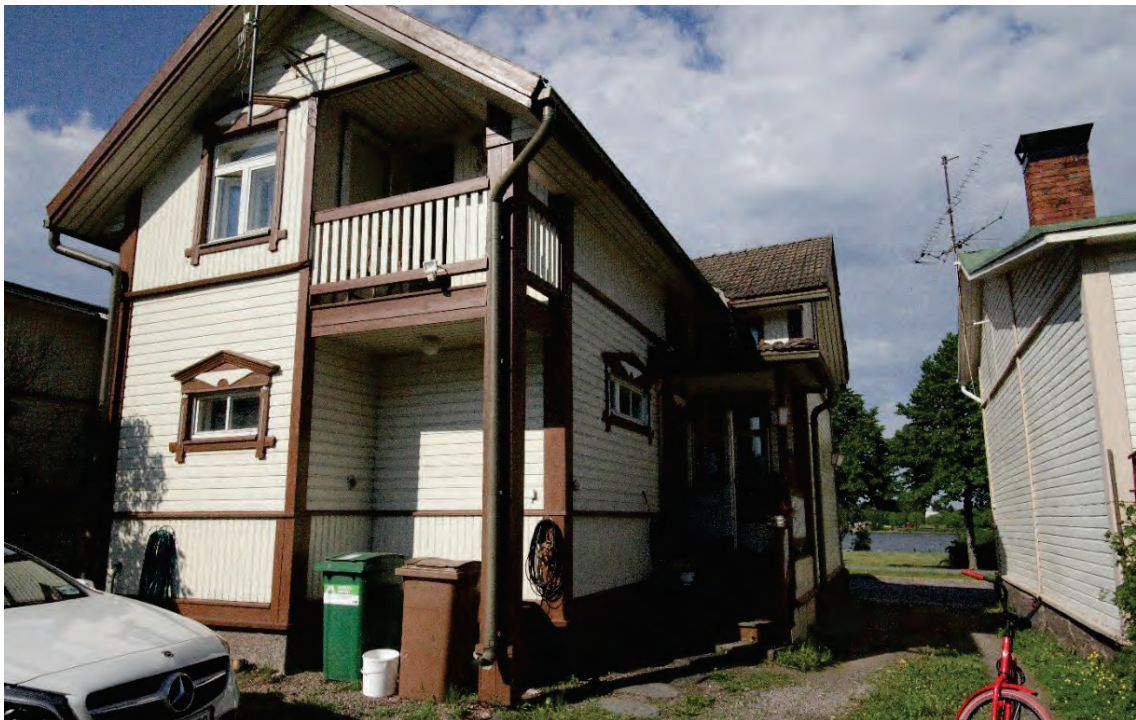
Kuva 4 Rantakatu 16 b:n asuinrakennusta on laajennettu pihan puolella leveällä poikkipäädellä. Kuvan oikeassa laidassa näkyvä talo sijaitsee samalla tontilla, mutta taloilla on omat rakennusten, aitojen ja kasvillisuuden rajaamat pihapiirinsä. Talojen välistä näkyy Rantakadun ja Rantapuiston yli merelle Pikkulahdelle. Rakennuksen ulkonäköä on kuvailtu edellä luvussa "Rakennuksen kuvaus".
