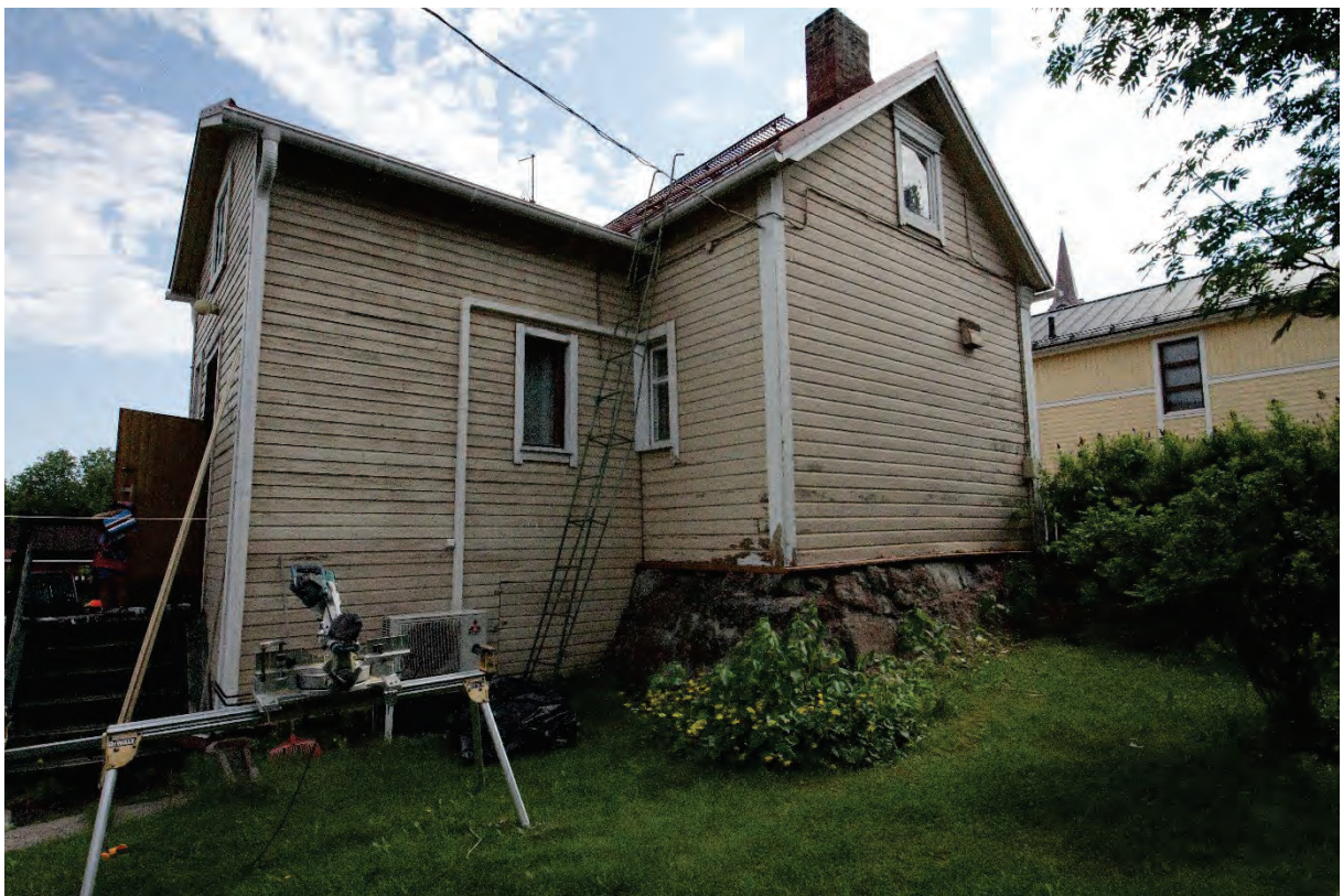
Kuva 3 Päärakennuksessa on pihan puolella umpikuisti, jonne on rakennettu 1970-80-lukujen taitteessa pesutilat. Rinteessä olevan talon kivijalka on pihan puolelta korkea ja tehty osittain luonnonkivistä. Rakennuksen ulkonäköä on kuvailtu edellä luvussa "Rakennuksen kuvaus".
