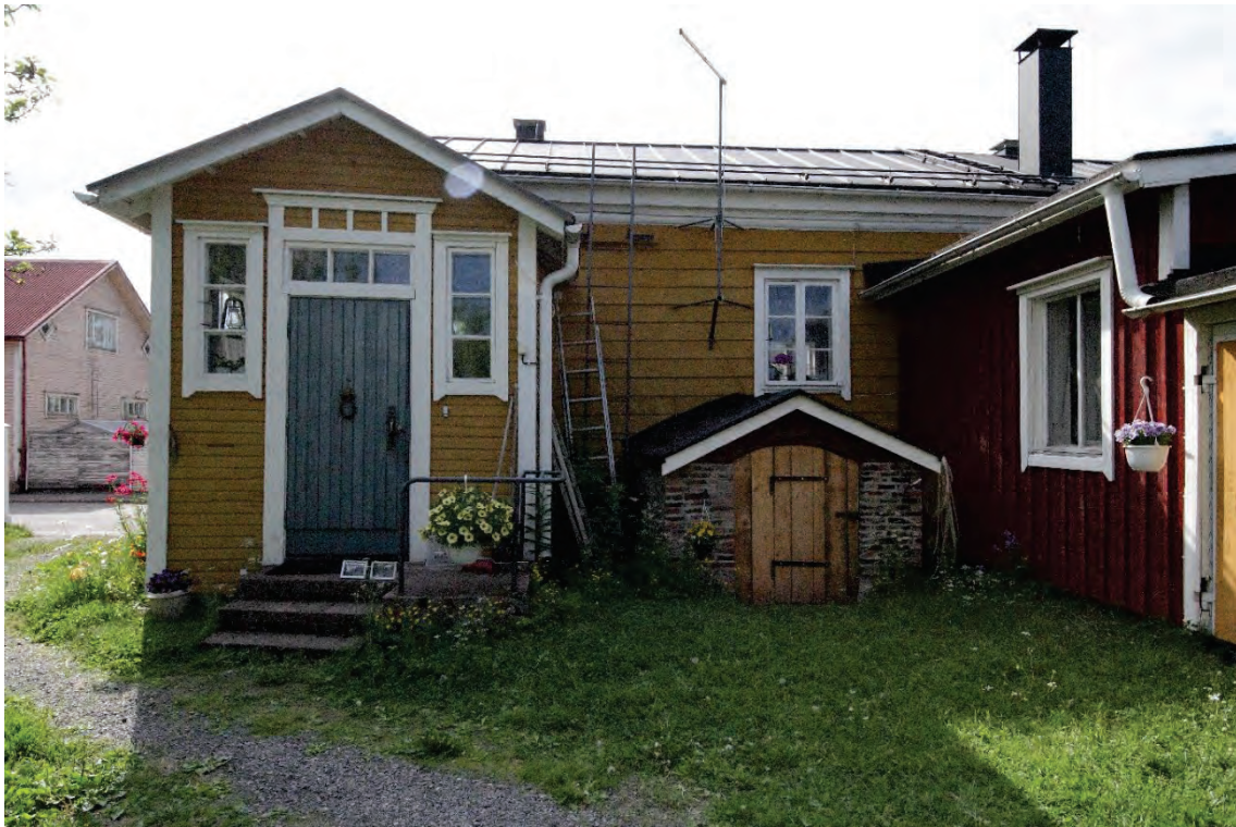
Kuva 5 Kohteen päärakennuksen pihan puoleisella julkisivulla on sisäänkäynti umpikuistin kautta. Kuistin vieressä on kellarin matala sisäänkäynti. Talousrakennusten rivistö on kiinni päärakennuksessa. Kuvan oikeassa reunassa näkyy entisen pakarin paikalle 1970-luvulla tehty uudisosa. Rakennuksen ulkonäköä on kuvailtu edellä luvussa "Rakennuksen kuvaus".
