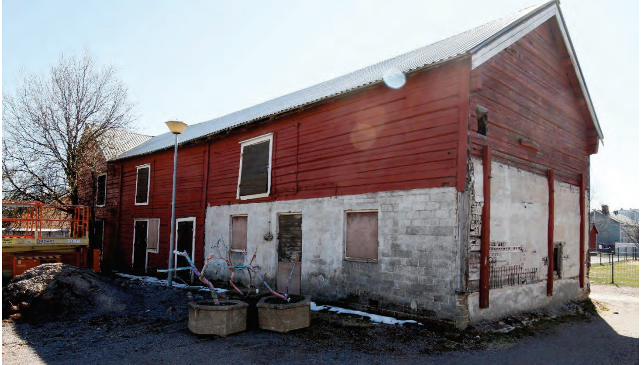
Kuva 2 Tontin eteläsivulle sijoittuu riviaitta, jonka länsipäätä on käytetty eläinsuojana. Eläinsuojaa on luultavasti käytetty navettana tai tallina ja sen yläpuolella on ylinen heiniä varten. Eläinsuojan lisäksi rakennuksessa on kolme muuta aittahuonetta. Rakennuksen ulkonäköä on kuvailtu edellä luvussa "Rakennuksen kuvaus".
