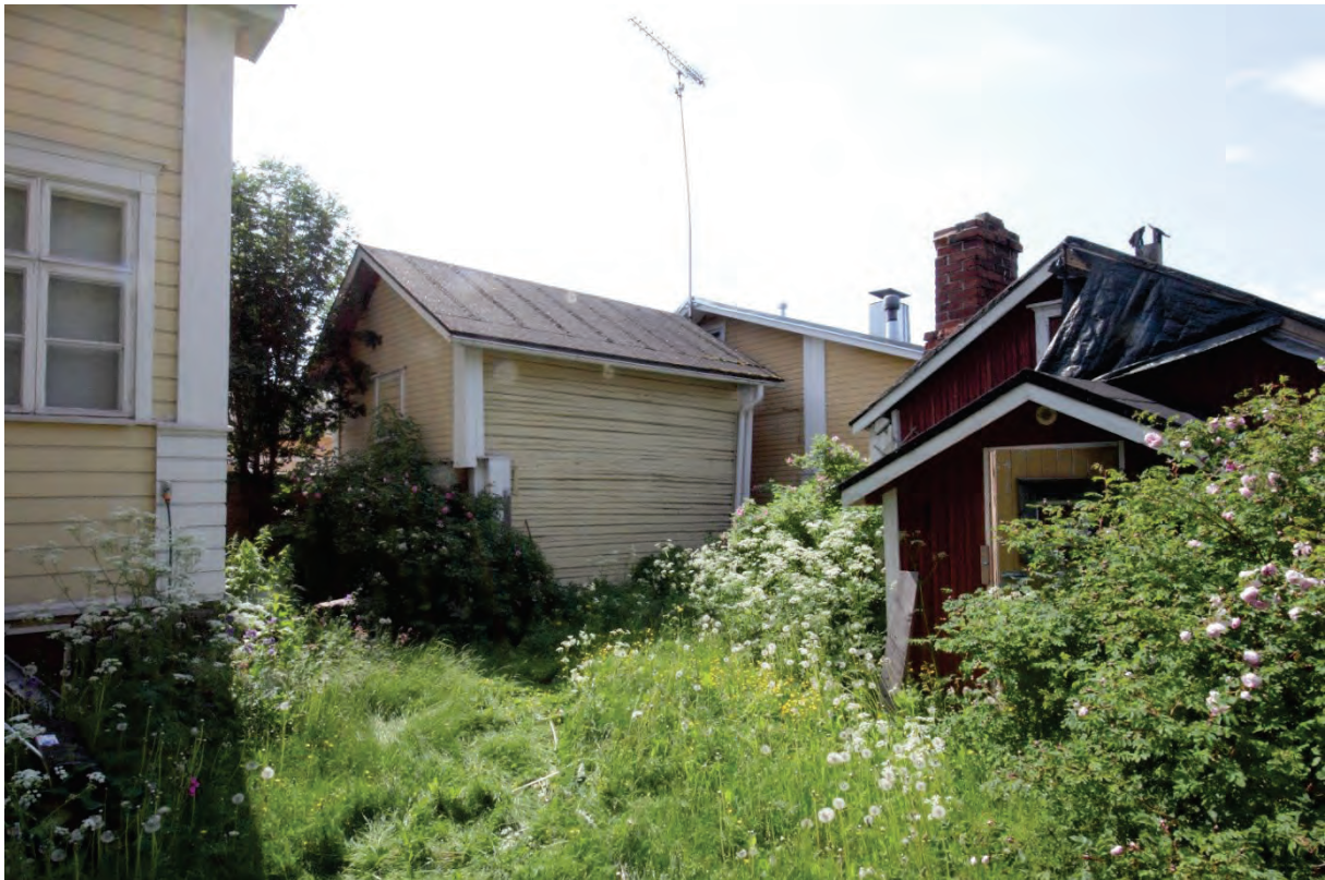
Kuva 4. Kuvassa keskellä näkyy kohteen aitta ja sauna pihalta kuvattuna. Aitan pihan puoleinen julkisivu on vuoraamaton. Rakennusten ulkonäköä on kuvailtu edellä luvussa "Rakennuksen kuvaus".
