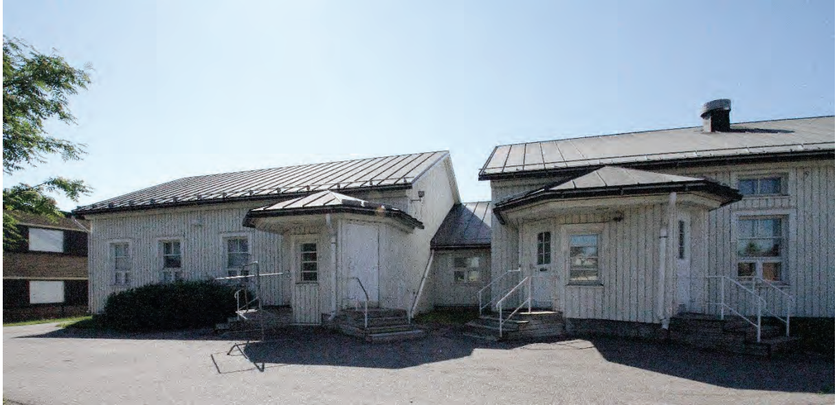
Kuva 4. Päiväkodin itäjulkisivu koostuu kahdesta käytävän toisiinsa liittämästä rakennusosasta, joiden mittakaava noudattaa vanhan kaupungin asuinrakennusten mittakaavaa. Itäjulkisivulla on kaksi sisäänkäyntikuistia, joiden muotokieli on moderni tulkinta mutterikuistista. Rakennuksen ulkonäköä on kuvailtu edellä luvussa ”Rakennuksen kuvaus”.
