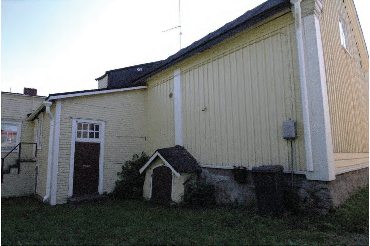
Kuva 3. Päärakennuksen pihanpuoleinen julkisivu ja pääty. Pihanpuolella on lapekattoinen kuisti ja kellarin sisäänkäynti. Pihan puolella rakennuksen kulmassa on pilasteri, jolla ei ole jalustaa mutta koristeellisesti profiloitu kapiteeli. Rakennuksen ulkonäköä on kuvailtu edellä luvussa "Rakennuksen kuvaus".
