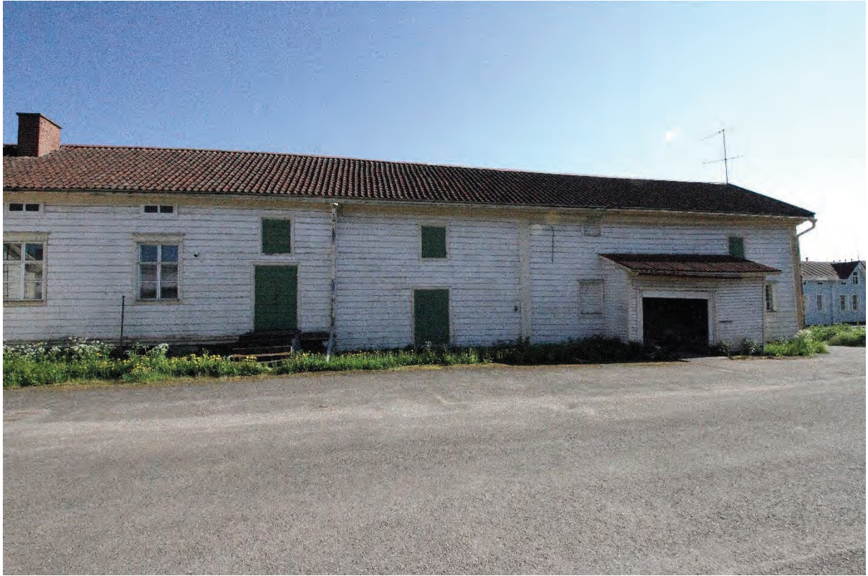
Kuva 6. Friemanin talon Kauppakadun puoleisen siiven pihajulkisivu. Liiketilöjen takana on ollut varastomakasiinit, joihin johtaa vihreät ovet. Ovien yllä on luukut yläkerroksen varastotilöihin. Kuvan oikeassa laidassa näkyy huolintaliikkeen aikainen lastauslaituri katoksineen. Rakennuksen ulkonäköä on kuvailtu edellä luvussa "Rakennuksen kuvaus".
