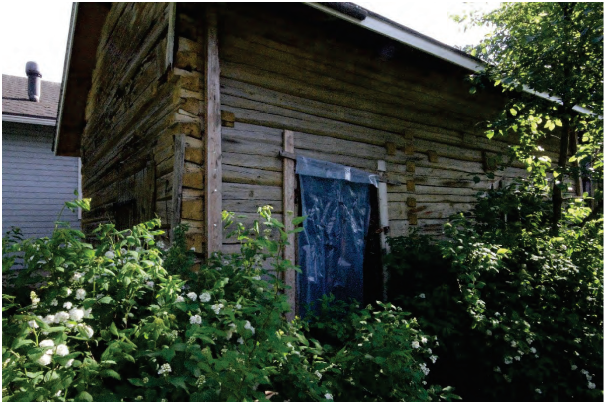
Kuva 8. Tontin eteläreunalla olevan talousrakennuksen itäpäädyssä on entinen navetta. Navetta on kengitetty 2000-luvulla ja hirsirakennetta tuettu följareilla. Rakennuksen päädyssä näkyy, että siihen on aiemmin liittynyt muita talousrakennuksia, jotka on purettu.
