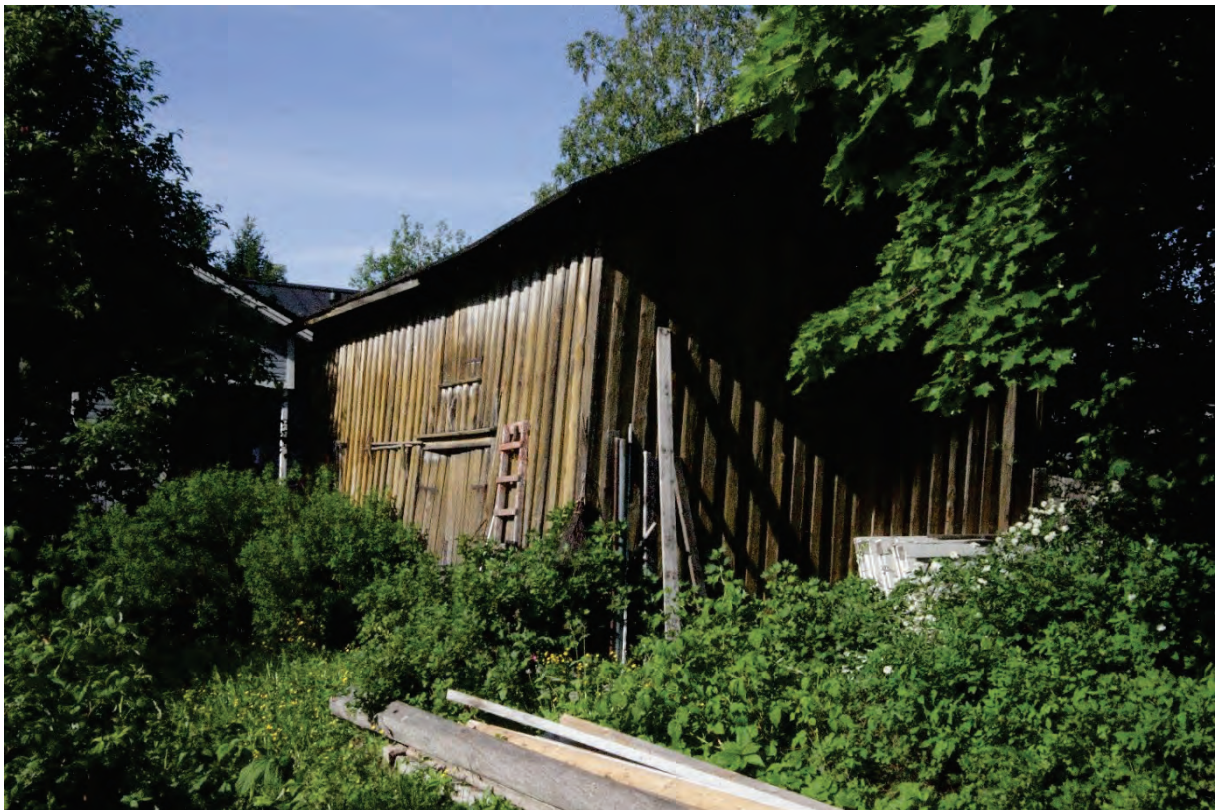
Kuva 4. Kuvan vasemmassa laidassa näkyy rakennuksen eteläosan runkoa ja pihan puoleinen laajennusosa. Kuvan oikeassa reunassa näkyy pohjoisemman rakennusosan kulmassa oleva mutterikuisti ja kaunis vanha parillinen peiliövi. Kuistin ja laajennusosan välistä seinävuoraus on purettu ja vanhat hirret ovat näkyvillä. Rakennuksen ulkonäköä on kuvailtu edellä luvussa "Rakennuksen kuvaus".
