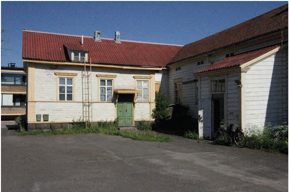
Kuva 5. Friemanin talon Kirkkokadun puoleisessa siivessä on iso lapekattoinen umpikuisti ja vanha pariovi. Pihan puolella siiven vesikatteena on aaltopelti. Kauppakadun puoleisen siiven kuisti on pienempi lapekattoinen umpikuisti. Myös siinä on vanha pariovi. Kellarin sisäänkäynti sijaitsee rakennuksen kulmassa. Piha on lähes kauttaaltaan asfaltoitu. Rakennuksen ulkonäköä on kuvailtu edellä luvussa "Rakennuksen kuvaus".
