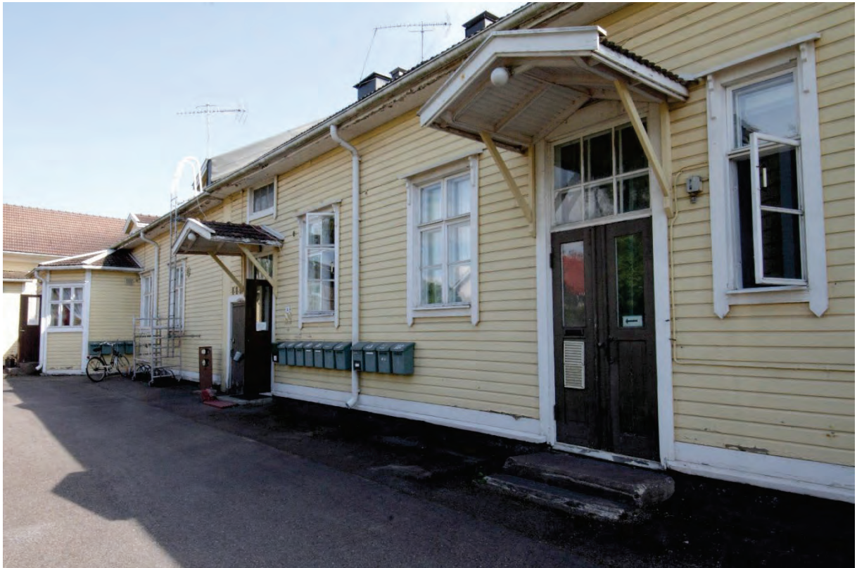
Kuva 5. Koulukadun puoleisen siiven pihajulkisivulla on kaksi sisäänkäyntiä, joiden päällä on katos. Ovet ovat ruskeaksi maalatut ikkunalliset pariovet. Kuvan vasemmassa reunassa näkyy lisäksi mutterikuisti, josta on myös sisäänkäynti rakennukseen. Pihajulkisivussa ei ole vastaavia koristeita kuin katujulkisivuissa. Rakennuksen edusta on kauttaaltaan asfaltoitu. Rakennuksen ulkonäköä on kuvailtu edellä luvussa "Rakennuksen kuvaus".
