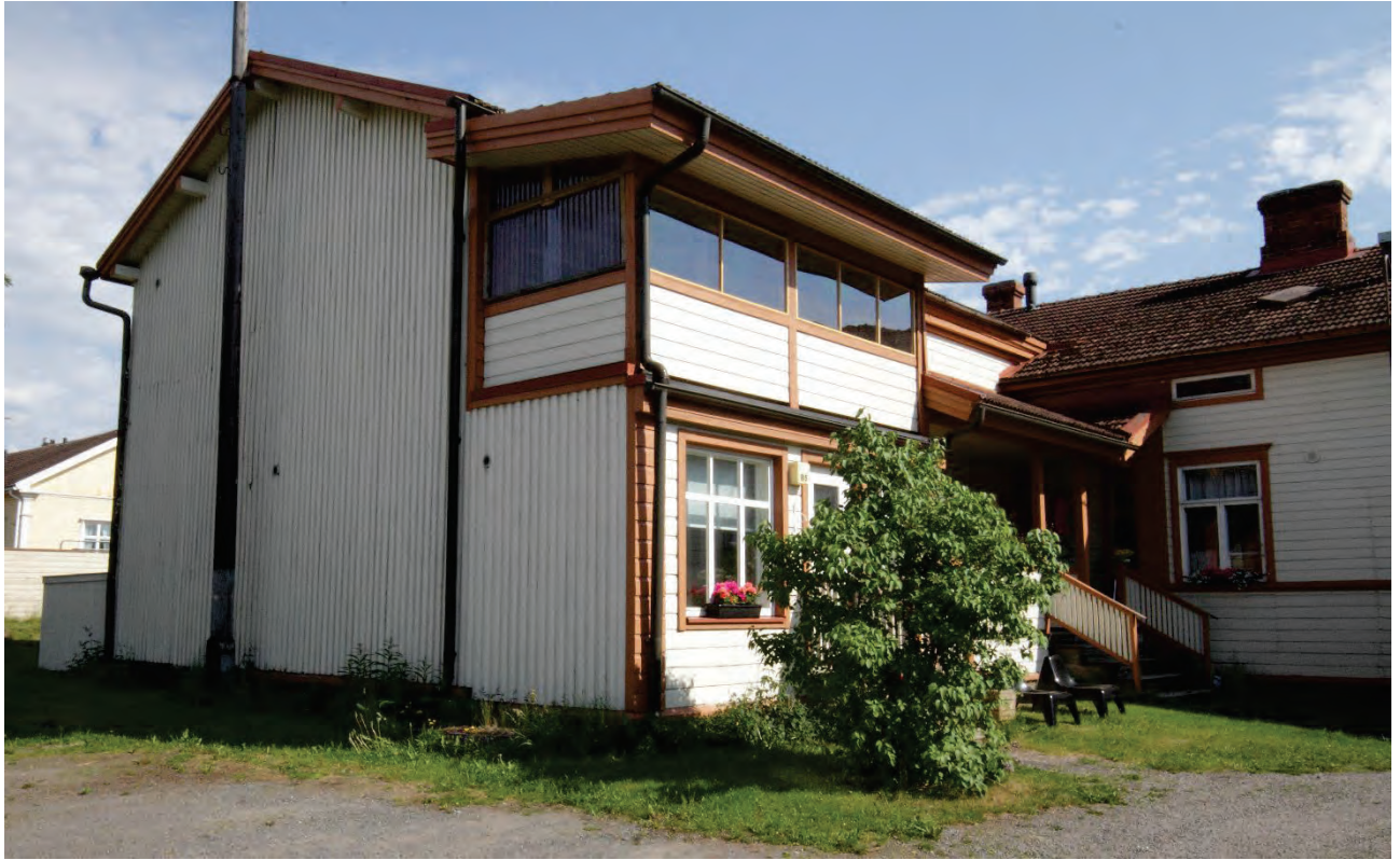
Kuva 4. Koulukadun puoleisen päärakennuksen pihan puoleinen julkisivu. Vasemmalla näkyy rakennuksen vanhempaa osaa, jonka edustalla on kuisti, jonka päällä on lasitettu parveke. Kuistin ja Koulukadun puoleisen rakennusosan välissä on avokuisti. Oikealla näkyy rakennuksen Koulukadun suuntaista laajennusosaa. Rakennuksen ulkonäköä on kuvailtu edellä luvussa "Rakennuksen kuvaus".
