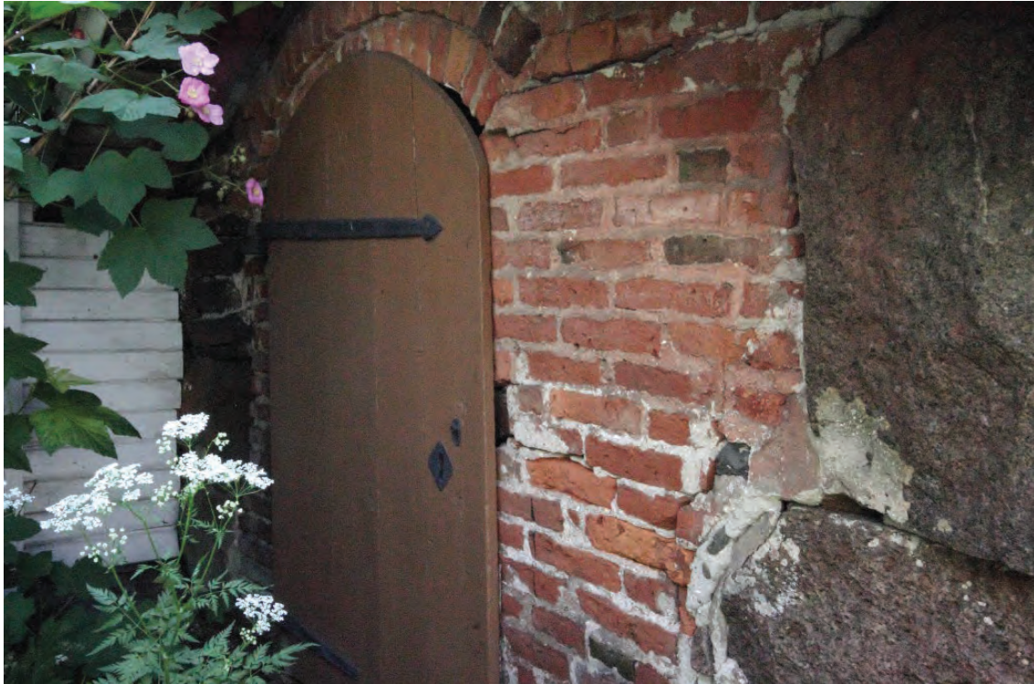
Kuva 6. Kellarin sisäänkäynti. Kellari on rakennettu osittain lohkokivistä ja osittain tiilimuurattu. Oven ympäristö on tiilirakenteinen ja oviaukko on holvimuurattu. Lautaovi on maalattu ruskeaksi.
