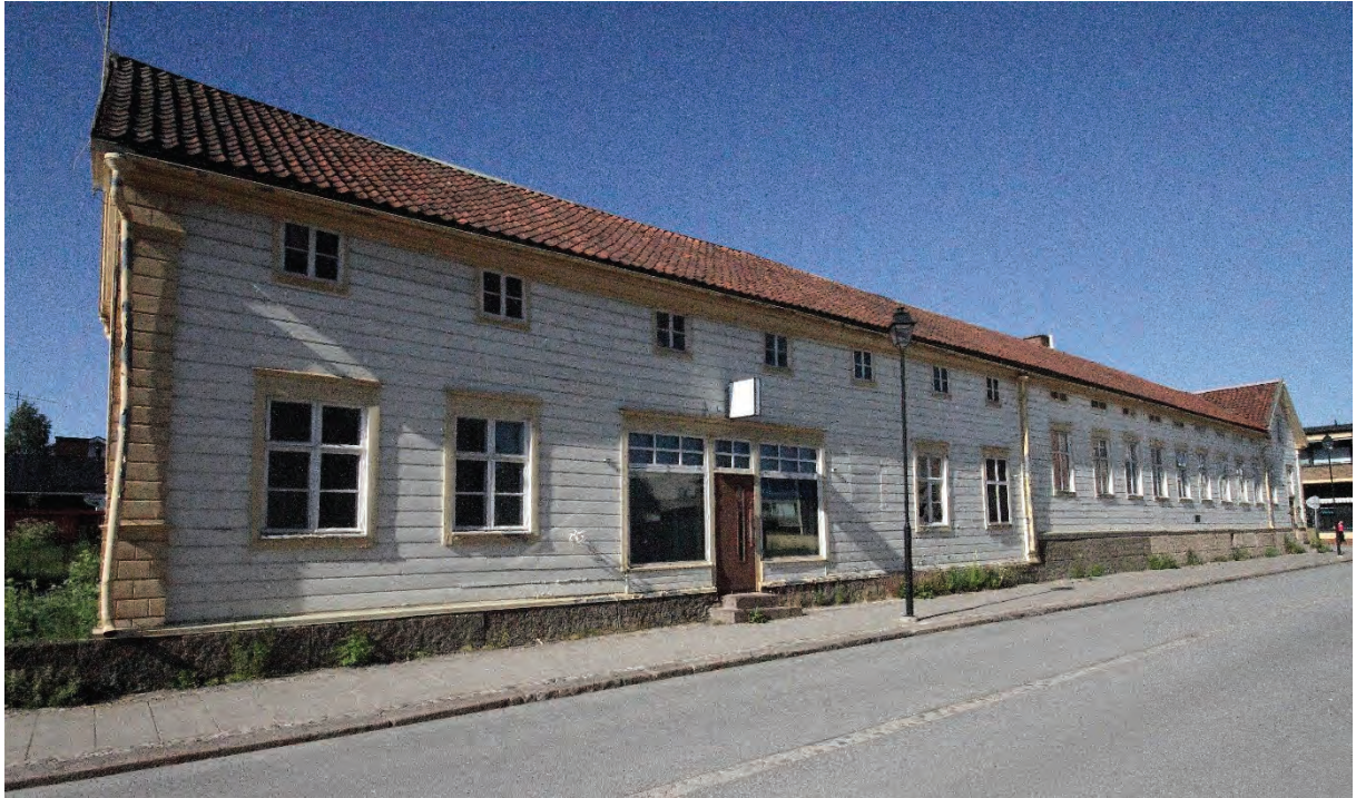
Kuva 4. Friemanin talon liiketilat Koulukadun varrella rakennuksen länsipäässä. Liiketilojen kivijalka on muuta rakennusta matalampi ja ullakkokerros korkeampi räystäslinjan ollessa kuitenkin yhtenäinen. Liiketilojen keskellä on kaksi isoa näyteikkunaa, joiden välissä on ovi liiketiloihin. Liiketilassa on viimeksi toiminut huolintayritys. Rakennuksen ulkonäköä on kuvailtu edellä luvussa "Rakennuksen kuvaus".
