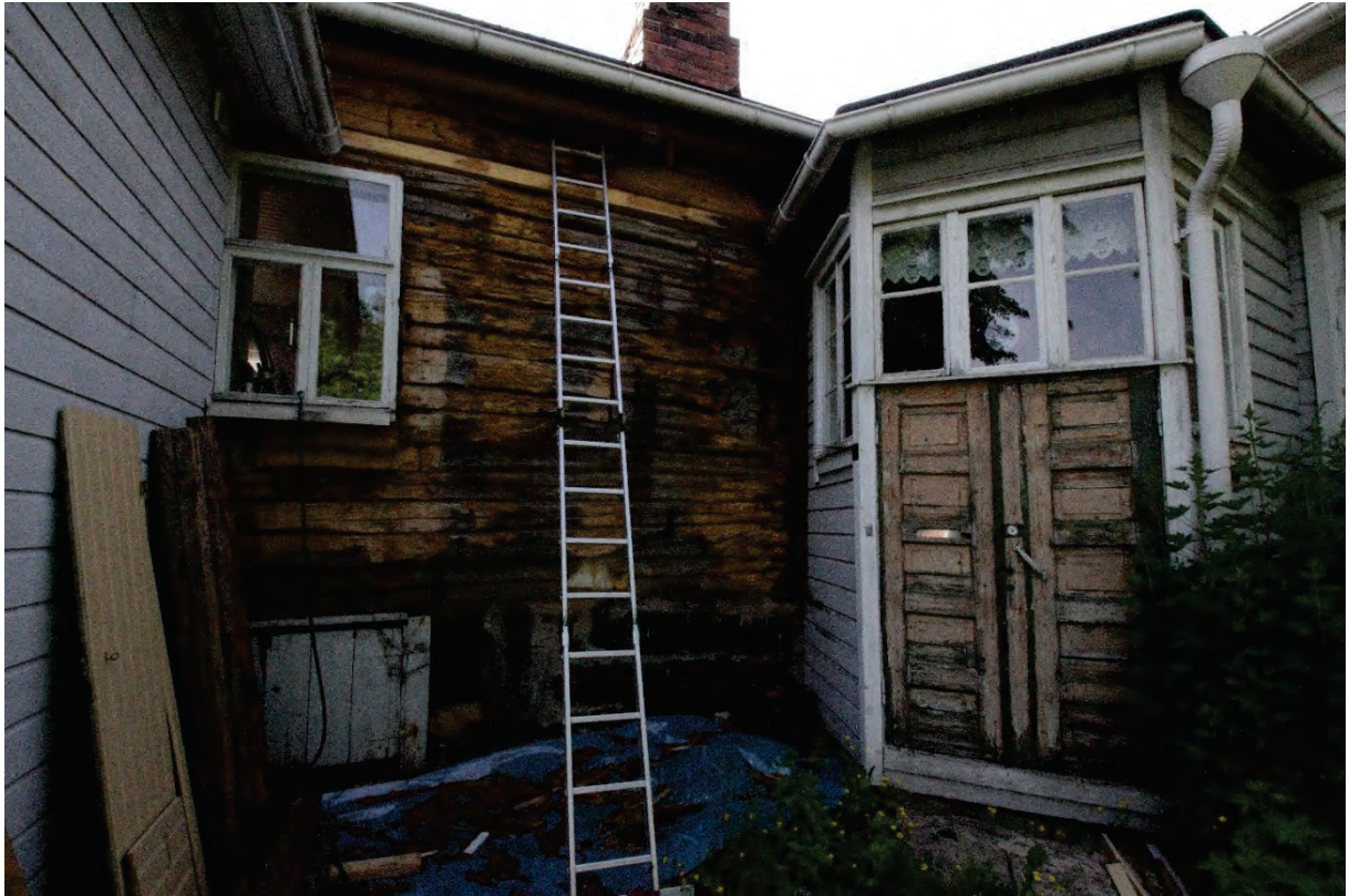
Kuva 4. Kuvan vasemmassa laidassa näkyy rakennuksen eteläosan runkoa ja pihan puoleinen laajennusosa. Kuvan oikeassa reunassa näkyy pohjoisemman rakennusosan kulmassa oleva mutterikuisti ja kaunis vanha parillinen peiliövi. Kuistin ja laajennusosan välistä seinävuoraus on purettu ja vanhat hirret ovat näkyvillä. Rakennuksen ulkonäköä on kuvailtu edellä luvussa "Rakennuksen kuvaus".
