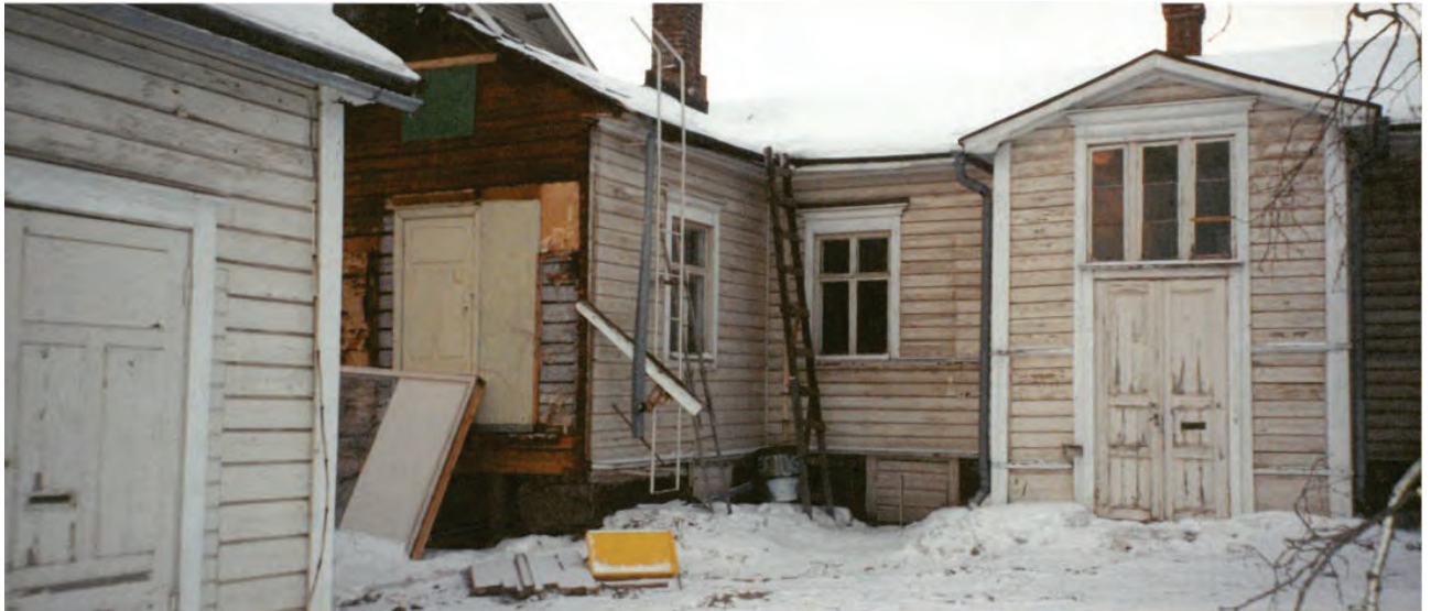
Kuva 8. Valokuva kohteen päärakennuksen pihanpuoleisesta julkisivusta ennen vuotta 2000 tehtyä remonttia. Kuvan vasemmassa reunassa näkyy tontin länsilaidalla edelleen oleva toinen asuinrakennus. Sen ja päärakennuksen välistä on purettu ne yhdistänyt rakennusosa. Päärakennus on vaakaverhoiltu ja vaaleanpunaiseksi maalattu. Ikkunat ovat neliruutuisia pystyikkunoita palkistokehyksin. Kuvan oikeassa reunassa näkyy päärakennuksen sisäänkäyntikuisti, Kuistille johtaa pariovi, jonka yläpuolella on isohko ikkuna.
