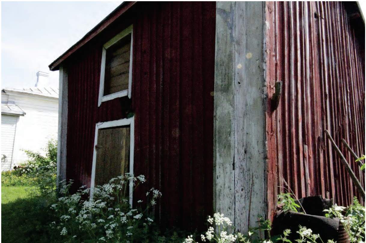
Kuva 8. Kohteessa oleva aitta. Aitan sivulla on ovi ja sen yläpuolella luukku aitan ylempään kerrokseen. Rakennuksen ulkonäköä on kuvailtu edellä luvussa "Rakennuksen kuvaus".
