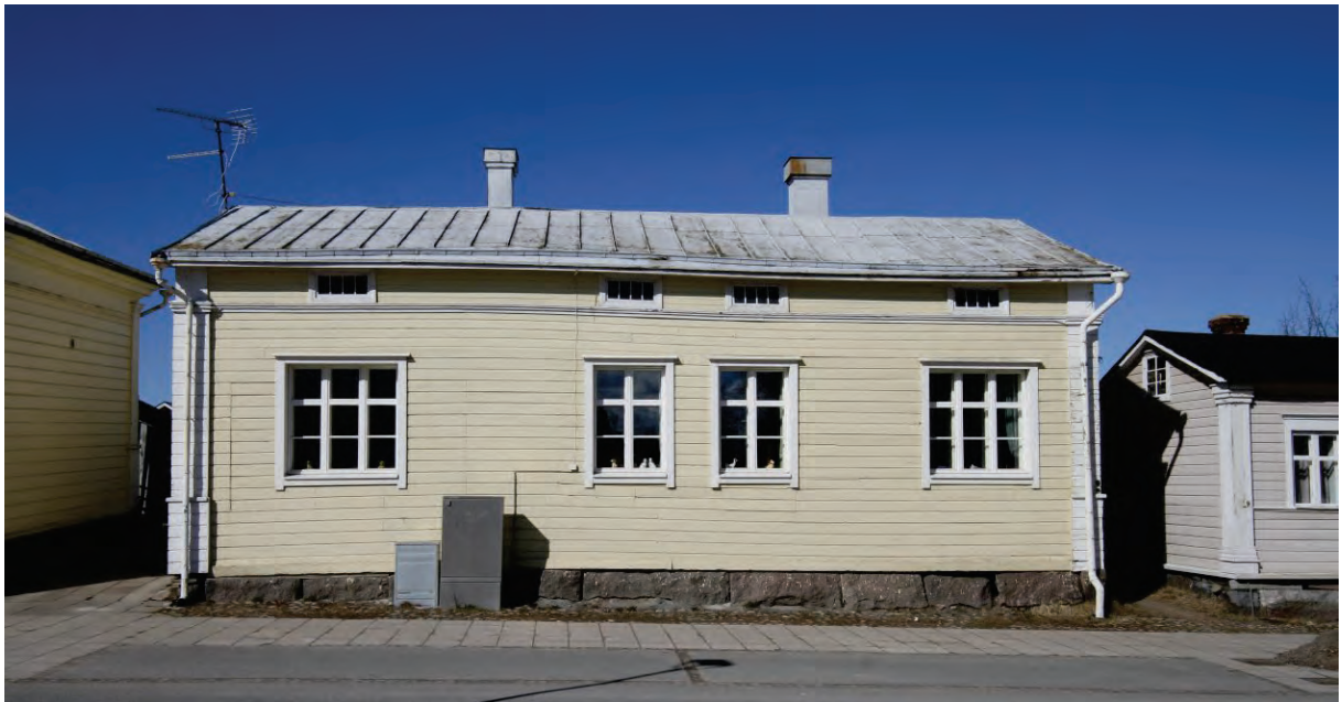
Kuva 3. Kohteen pohjoisemmän asuinrakennuksen Kirkkokadun puoleinen julkisivu. Kadulle päin on kaksi neliskulmaista, yhdeksänruutuista ikkunaa sekä niiden välissä kaksi kuusiruutuista pystyikkunaa. Kirkkokatu viettää rakennuksen kohdalta loivasti kohti pohjoista. Pohjoispuolisen tontin asuinrakennus on lähellä tontin rajaa ja rakennusten välistä on hyvin kapea kulkuaukko. Viereisen tontin asuinrakennus on selvästi matalampi kuin kohteen asuinrakennukset, vaakalaudoitettu ja sen nurkissa on piiloponttilaudoitetut pilasterit, joissa on sekä jalusta että kapiteeli. Kohteen pohjoisemmän asuinrakennuksen ulkonäköä on kuvailtu edellä luvussa "Rakennuksen kuvaus".
