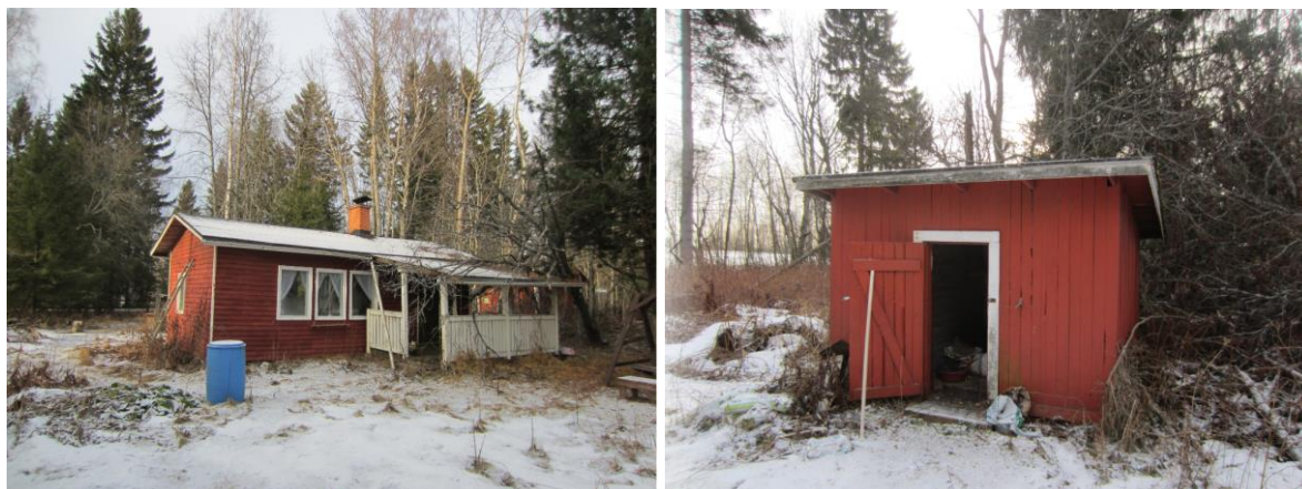
Kuva 3. Ulkofantintien 68 päärakennus ja varasto.
