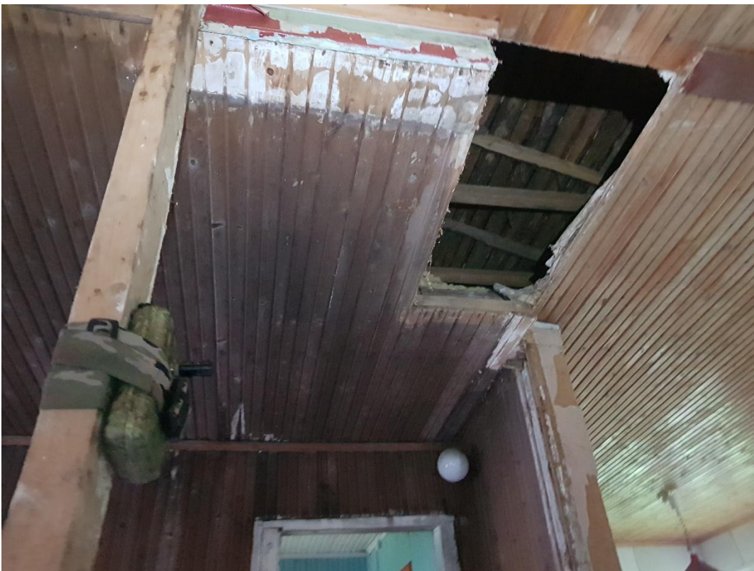
Passiivikartoitusta rakennuksen sisällä Uikofantintie 74:llä.
