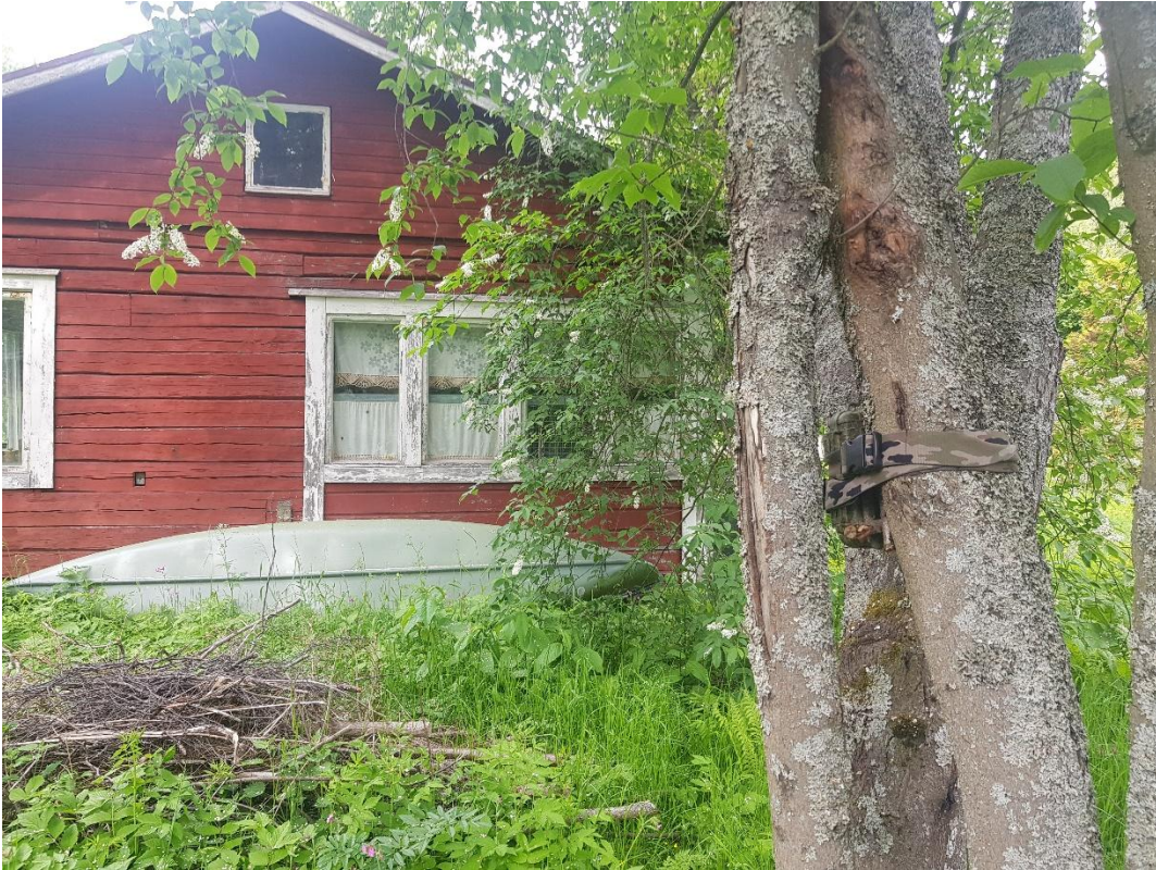
Passiivikartoitusta rakennuksen ulkopuolella Uikofantintie 74:llä.
