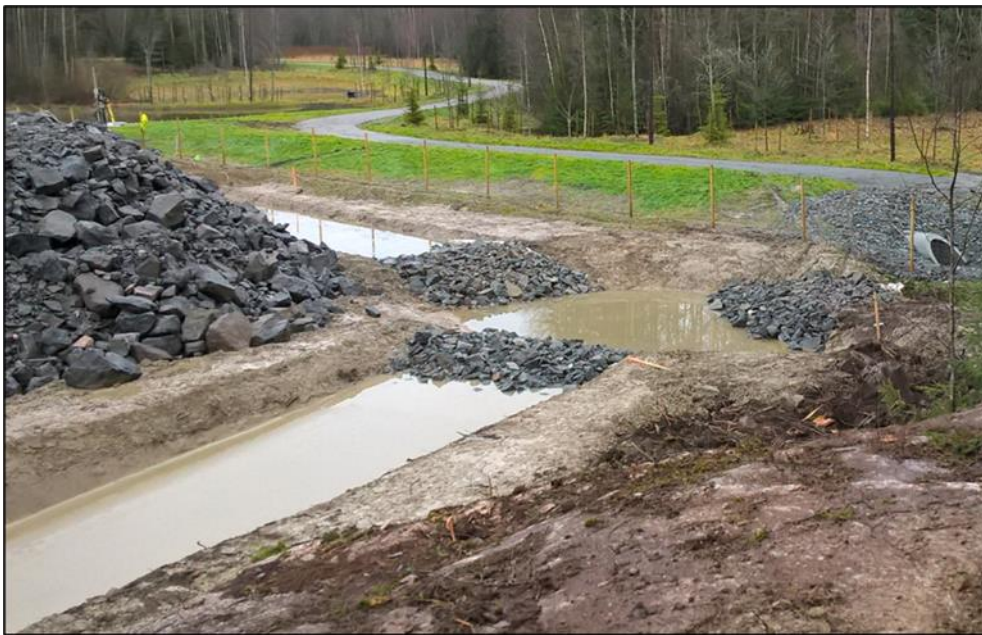
Kuva 9. Esimerkki rakentamisen aikaisesta laskeutusaltaasta ja suotopadosta.
