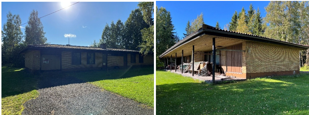
Kuva 17 Kirkkoherran asunto kuvattu etu- ja takapuolelta (FCG,2025).
