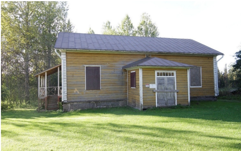
Kuva 31 Renkitupa kuvattuna pohjoisesta (FCG 2025).
