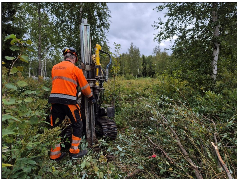
Kuva 3. Piste P019 kairausta. Pisteessä ei todettu otettujen näytteiden perusteella potentiaalisesti happamia sulfaattimaita.
