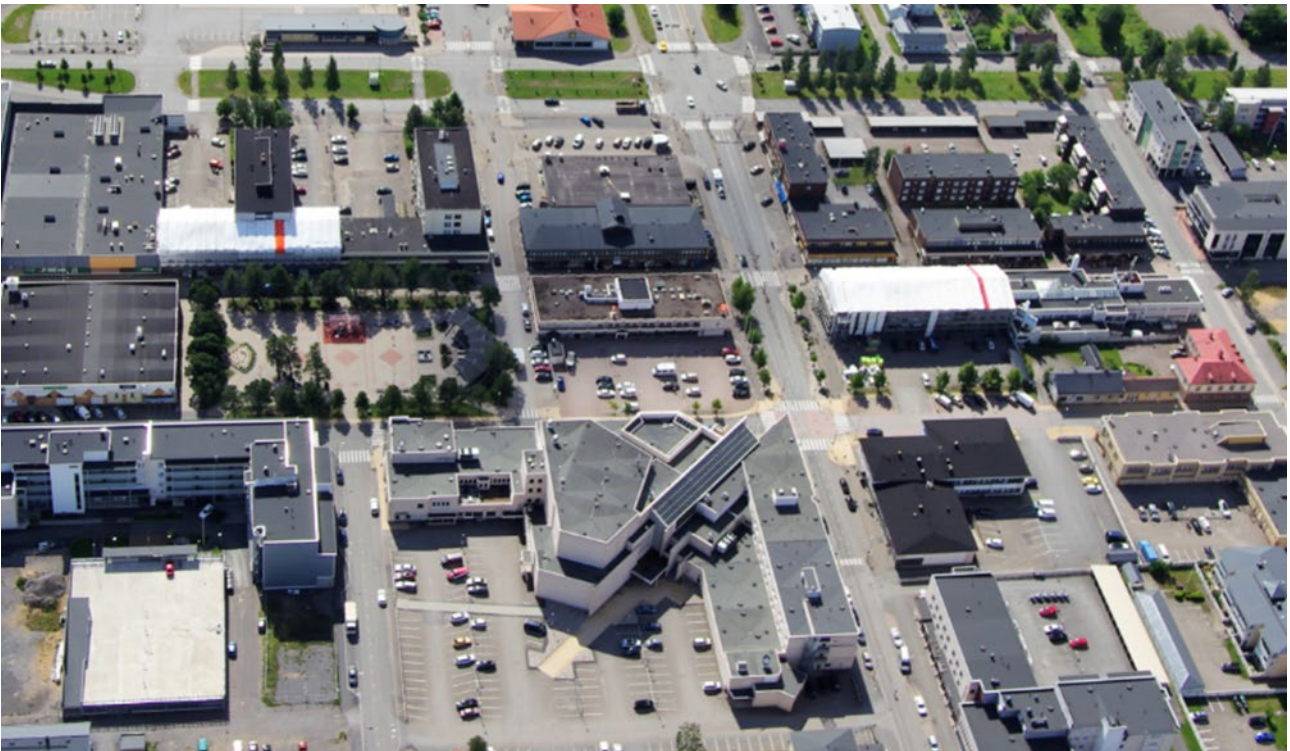
Kuva 3: Ote pohjoisen suunnasta kuvatusta ilmapäikälokuvasta. Liikekeskustan alue on rakennusvolyyymiltään Vanhaa kaupunkia selkeästi suurempaa. Kuvalähde: Raahen kaupunki, Aunola.
