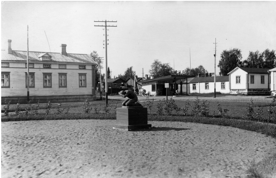
Kuva 21. Härkätori kuvattuna keskeltä lounaaseen päin. Kuva on ajoittamaton, mutta puiston istutuksista päätellen kuva on 1930-luvun alusta. Kuvan keskellä on Sovitus-patsas. Puistokäytävien ja katujen varsien havupuita ei ole vielä istutettu ja puiston keskellä olevaa aukiota reunustavat pensaat ovat vielä pieniä taimia. Torin lounaispuolella nykyisten Laivurinkadun ja Kumpeleenkujan risteyksessä on Shellin bensa-asema. Bensa-aseman loiva lapekatto suojaa myös bensapumppua. Kuvalähde: Raahen museo.
