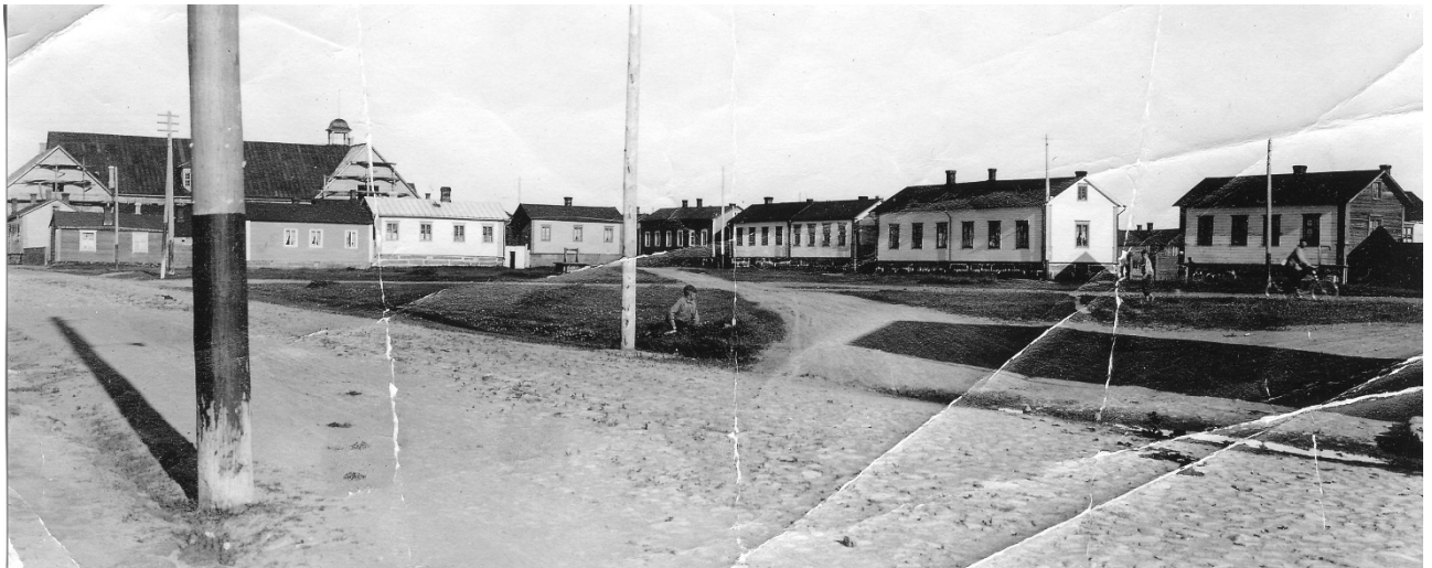
Kuva 11. Ajoittamaton valokuva Härkätorista ilmeisesti 1910-luvulta. Kuva on otettu torin luoteiskulmalta kohti kaakoa. Vasemmassa reunassa näkyvä Raahela vuorattiin vuosikymmenen lopulla ja kuvassa Raahelaa ympäröivät rakennustelineet. Tori on osin nurmipintainen ja sitä halkoo oikoreitit torin poikki. Torin etelälaidalla kuvan oikeassa reunassa on suurehkoja, melko vauraan näköisiä taloja. Kahden oikeanpuolimmaisien talon välissä on Reiponkadun jatke etelään. Torin itälaidalla Raahelan edustalla rakennukset ovat selvästi pienempiä ja vaatimattomampia. Niiden takaa näkyy Raahela, jota ympäröi vielä rakennustelineet. Kuvalähde: Raahen museo.
