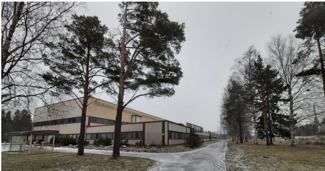
Kuva 4 Entisen Aikuiskoulutuskeskuksen päärakennus kaakkoiskulmalta.
