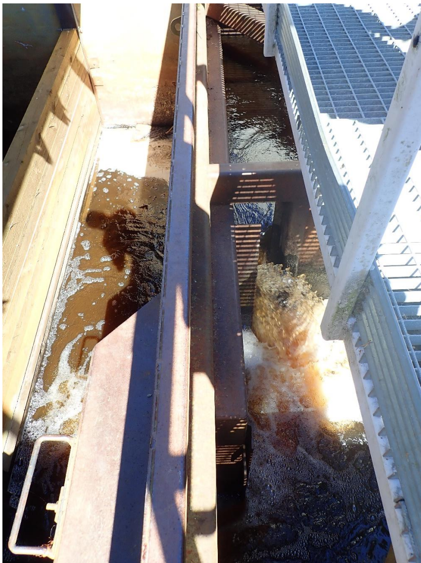
Kuva 12. Piehingin padon kalatie kesällä 2018. Kuvassa näkyvän kynnyksen korkeus ja virtausnopeus olivat liian suuria kalojen kulkemisen kannalta. (Kuva: ELY-keskus)
