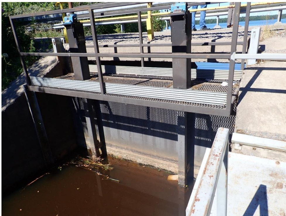
Kuva 5. Mutalan padolla säädellään Kuljunlahden vedenpinnankorkeutta. (Kuva: ELY-keskus)
