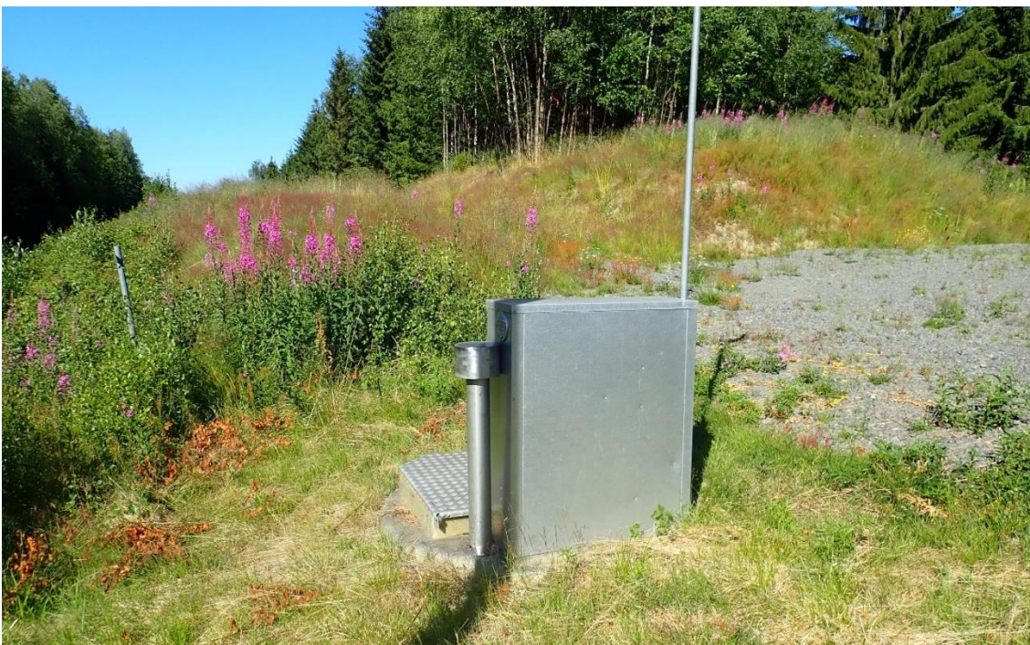
Kuva 3. Pattijoen pumppaamo. Pumppaamo ei ollut toiminnassa kesällä 2018. (Kuva: ELY-keskus)
