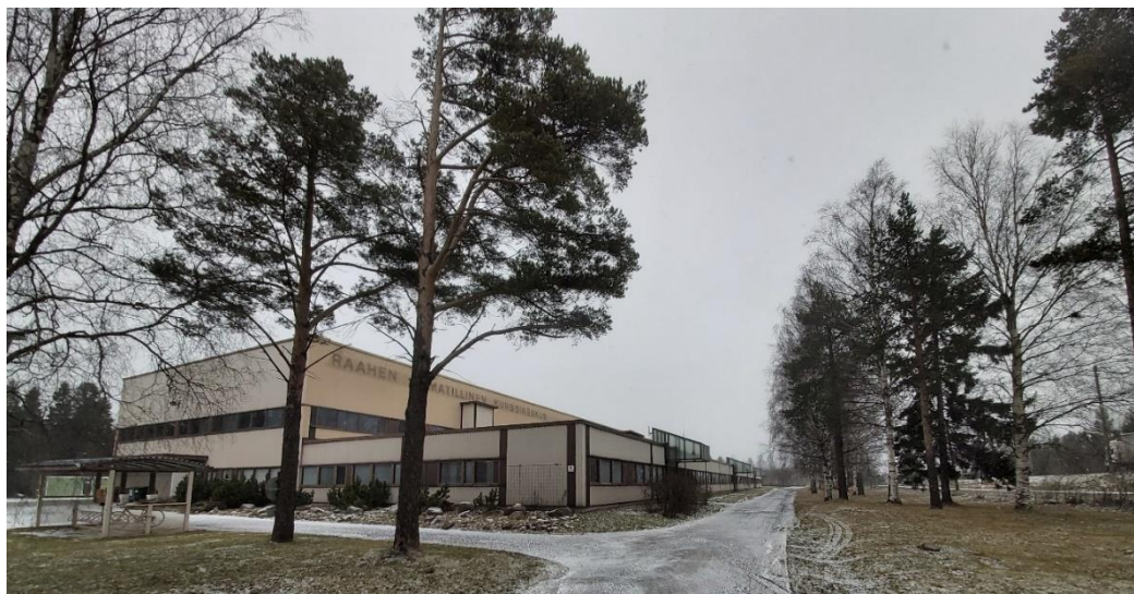
Kuva 4 Entisen Aikuiskoulutuskeskuksen päärakennus kaakkoiskulmalta.
